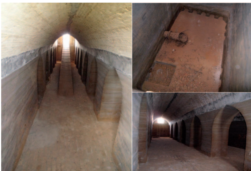
Figura 8. Vistas interiores del depósito de La Casa de las Aguas
