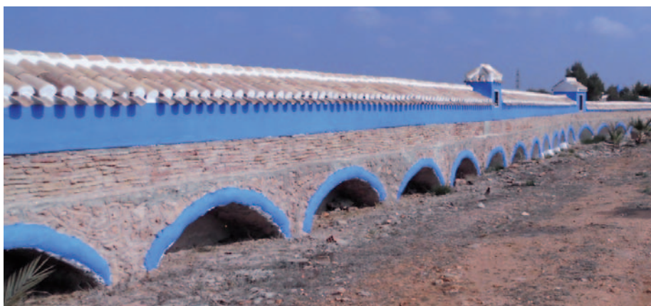
Figura 10. Canal cubierto en el interior de la Casa de las Aguas
