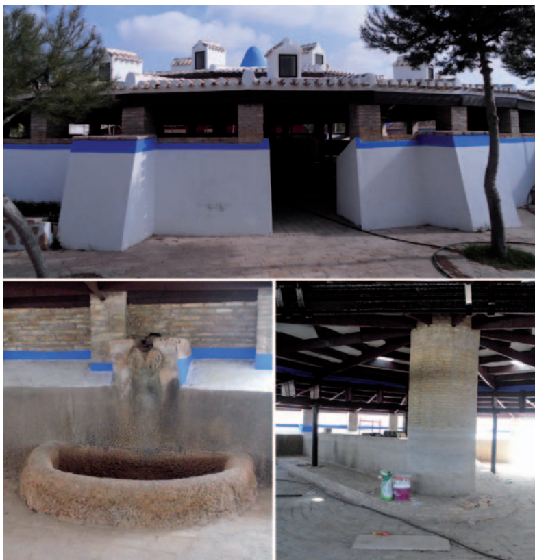
Figura 9. Decantador de la Casa de las Aguas
