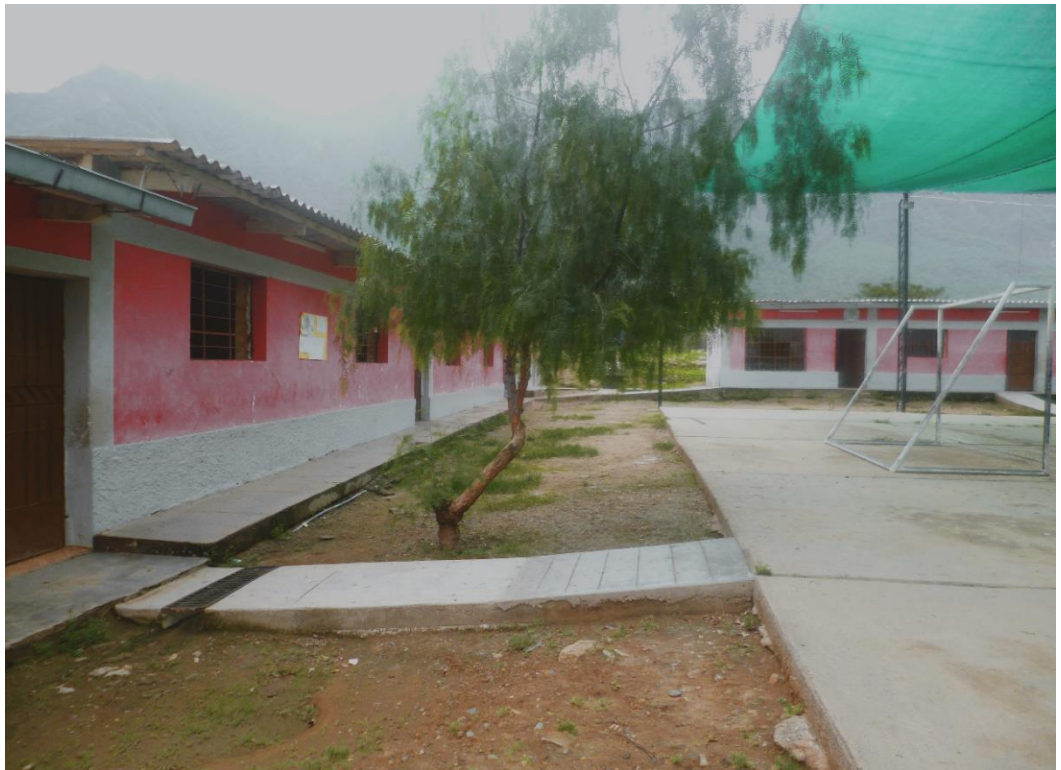
Situación Actual Infraestructura Educativa Primaria.
