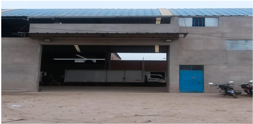
Figura 23. Fachada principal del almacén
