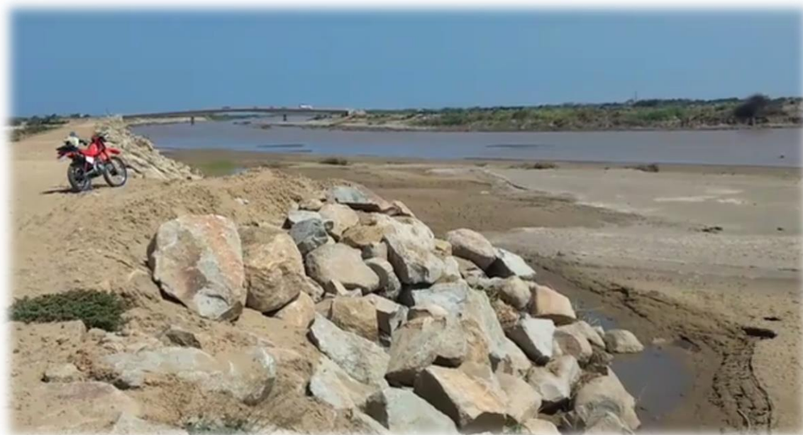
Anexo 3.14: Falla de la Defensa existente tras el fenómeno del niño costero.
