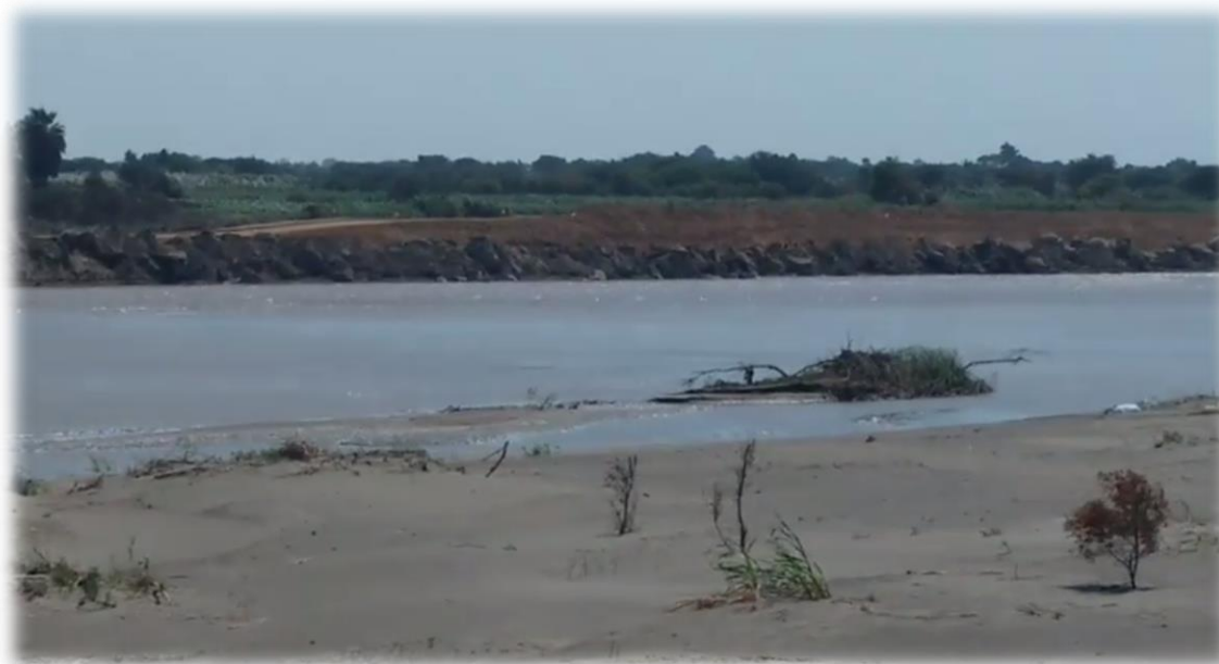
Anexo 3.15: Socavación de la Defensa por causas del fenómeno del niño costero.
