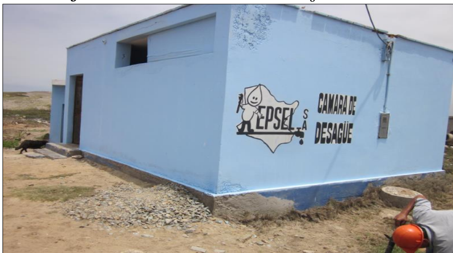
Imagen N° 18: Caseta de Bombeo de Aguas Residuales.
