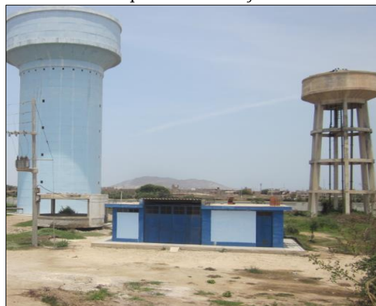
Imagen N° 14: Tanque elevado y Caseta de Bombeo.
