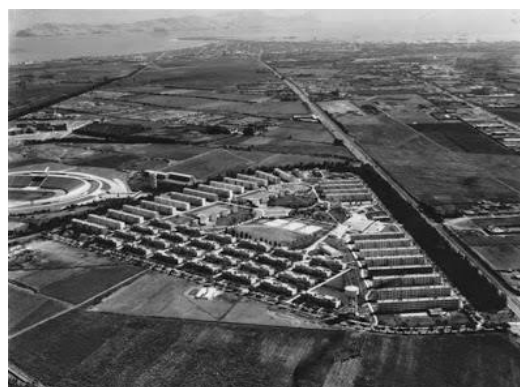
Imagen 23: Vista aérea de la Unidad Vecinal N°3
