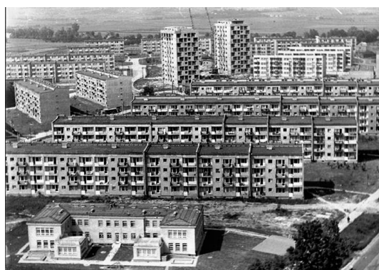
Imagen 13: Barrio situado al noreste de Moscú
