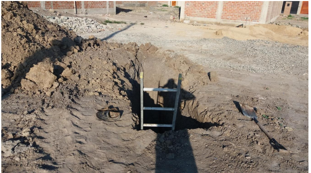
FOTOGRAFÍA 1.7: VISUALIZACIÓN CALICATA N° 5
