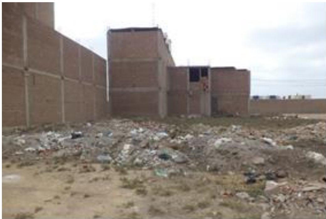
Figura 19. Infraestructura vial en la HUMLV (5)
