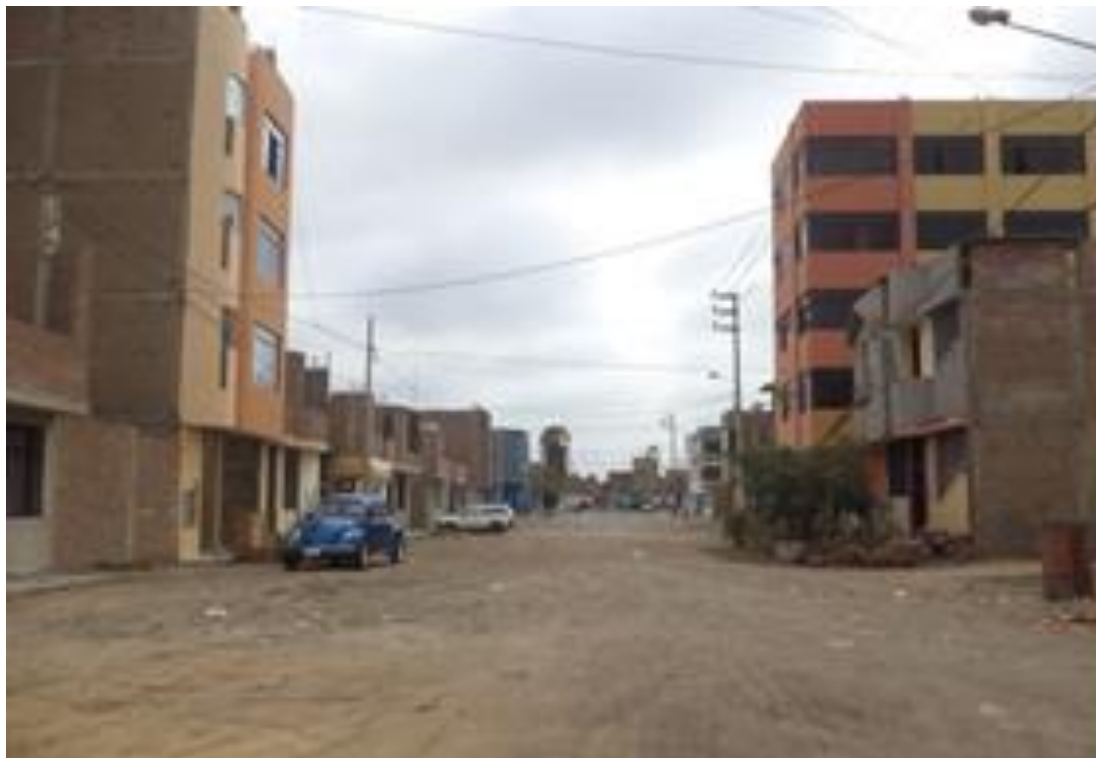
Figura 15. Infraestructura vial en la HUMLV (1)
