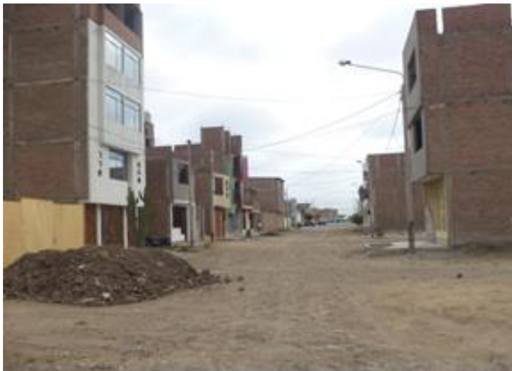
Figura 21. Infraestructura vial en la HUMLV (7)
