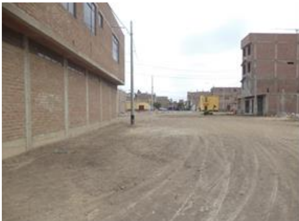
Figura 18. Infraestructura vial en la HUMLV (4)
