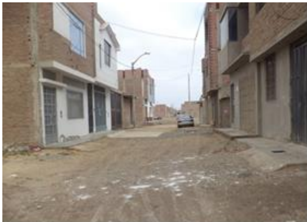
Figura 20. Infraestructura vial en la HUMLV (6)
