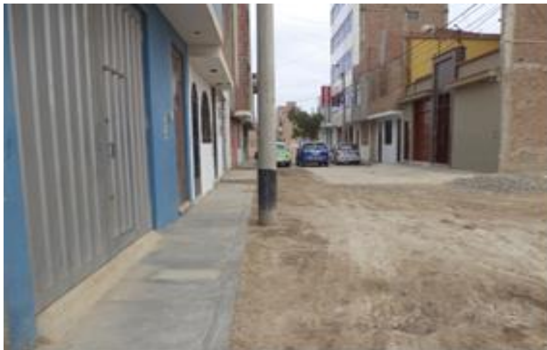
Figura 16. Infraestructura vial en la HUMLV (2)
