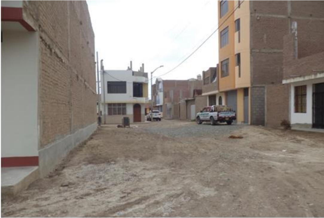
Figura 23. Infraestructura vial en la HUMLV (9)
