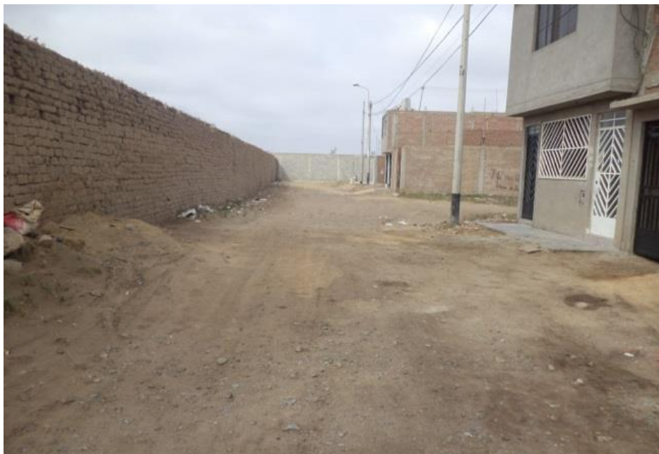
Figura 25. Infraestructura vial en la HUMLV (11)
