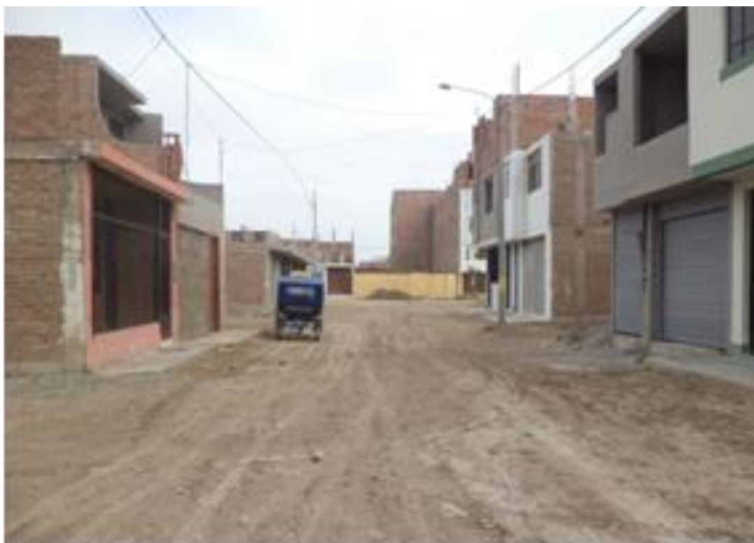
Figura 22. Infraestructura vial en la HUMLV (8)
