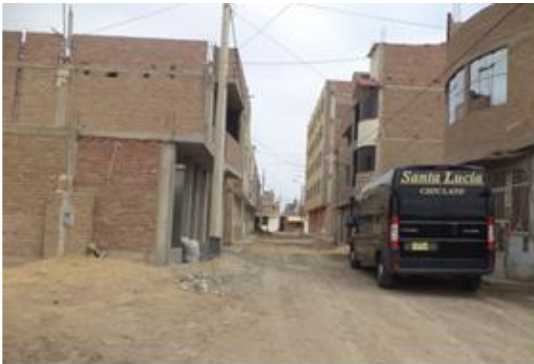
Figura 24. Infraestructura vial en la HUMLV (10)
