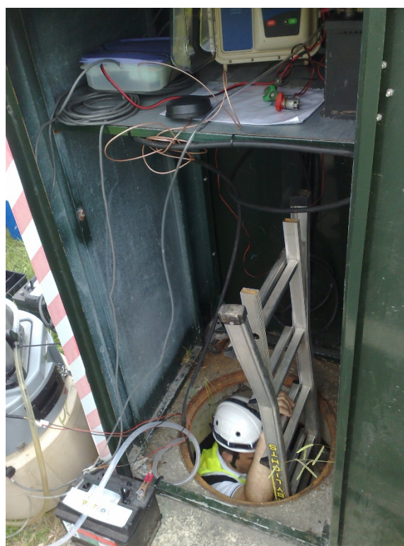
Figura 9.- Fase de colocación de instrumentación en la sección de control.
