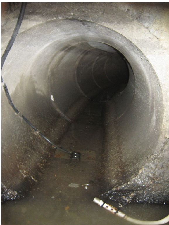
Figura 8.- Conducto de vertido hacia el mar. Debido a la existencia de un punto alto en la rasante se acumula una pequeña lámina de agua de 2-3 cm en la zona de medida. Se aprecia la situación de la pastilla de medida de velocidad y de calado.
