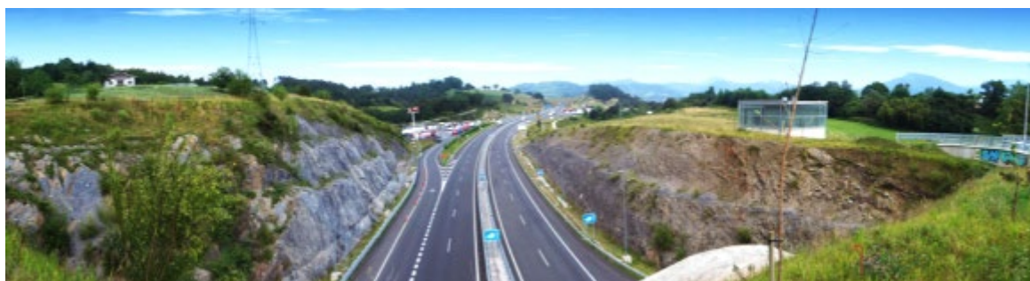
Figura 1.- Vista general del tramo de vial estudiado.
