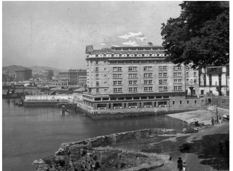
Fig. 13. Piscina, gimnasio y locales de La Solana, 1940 - 1942, del arquitecto Santiago Rey Pedreira y el ingeniero de caminos Rodolfo Lama Prada, A Coruña.
