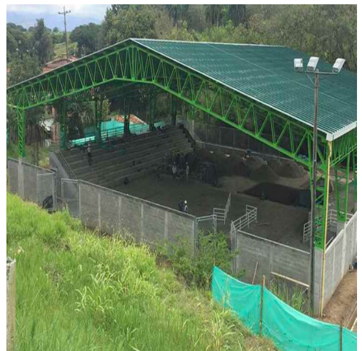
(f) Cubierta Puerto Caldas.
