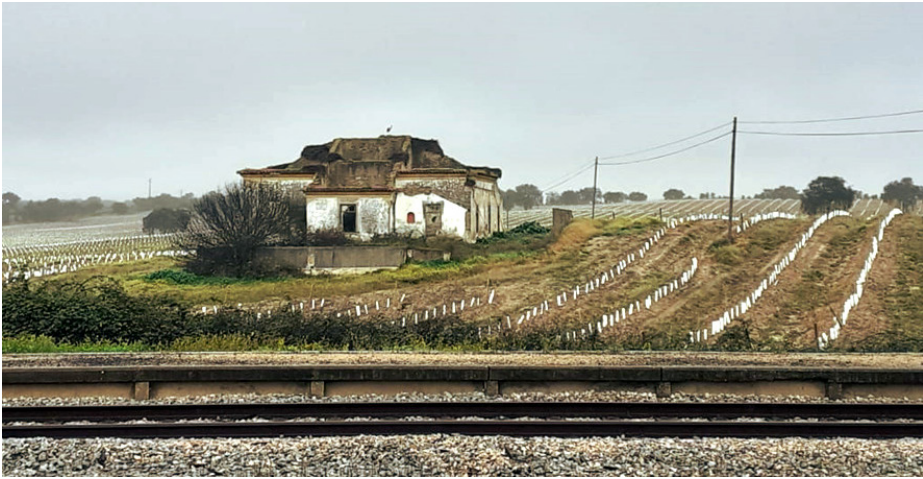
Fig. 4. Casa em Ruínas; Fotografia tirada a partir a Gare da Estação de Chança. Em primeiro plano, os carris da linha férrea. Em segundo plano, uma cegonha pousada no telhado da casa em ruínas e a área envolvente de olival, pontuada por postes de electricidade. Ao fundo, são visíveis outras árvores. ©Autores, 2020.
