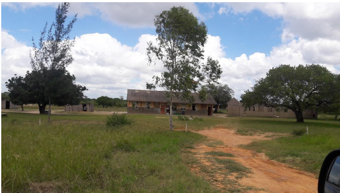
Figura 11 Vista frontal da EPC2, a esquerda vê-se duas das quatro salas construídas em material local, no centro o bloco administrativo com mais duas salas e a direita ainda em construção em material convencional um bloco de salas de aulas
