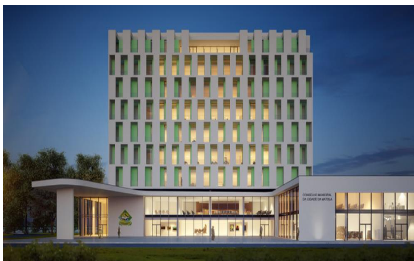
Figura 6 - Conselho Municipal da Matola, aplicação prática de palas para sombreamento (Sociedade de Engenharia, 2017).
