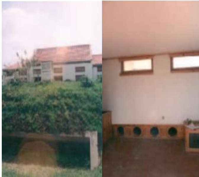
Figura 4 - Entrada exterior e interior dos tubos enterrados. (Gonçalves e Graça, 2004)
