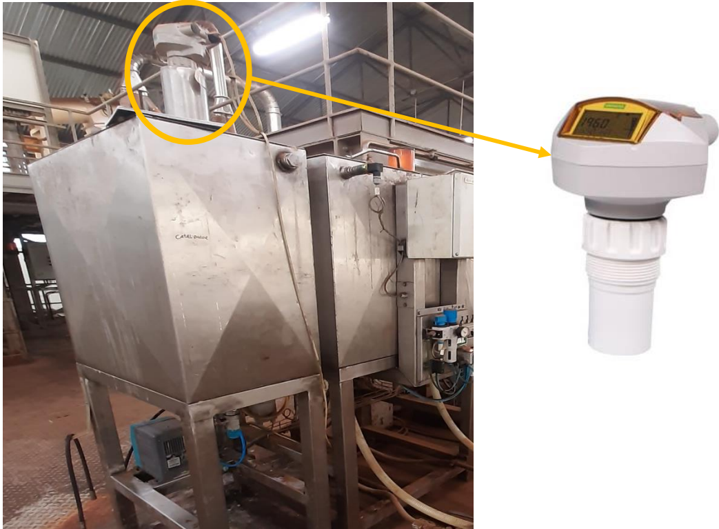
Figura 48 - Sensor Ultrassónico presente na Sistema de Doseamento da primeira secção
