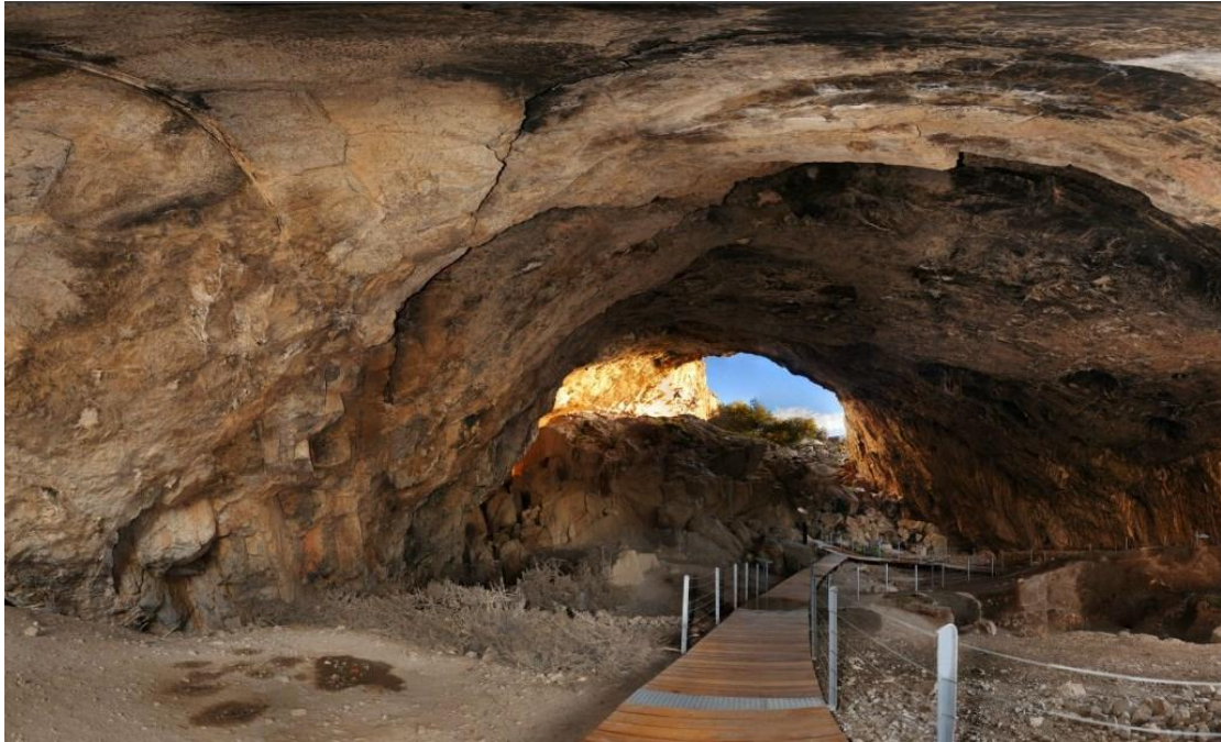
Εικόνα 5.2 Εσωτερική άποψη σπηλαίου Φράγγθι. Στο βάθος διακρίνεται η γκρεμισμένη οροφή
