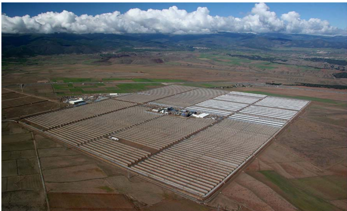
Εικόνα Α.8: Παραβολικά κάτοπτρα από το σταθμό Andasol solar power station στην Ισπανία [150 MW]
