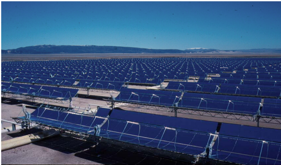
Εικόνα Α.7: Παραβολικά κάτοπτρα από το σταθμό Solar Energy Generating Systems (SEGS) στην Καλιφόρνια (U.S.A.) [394 MW]
