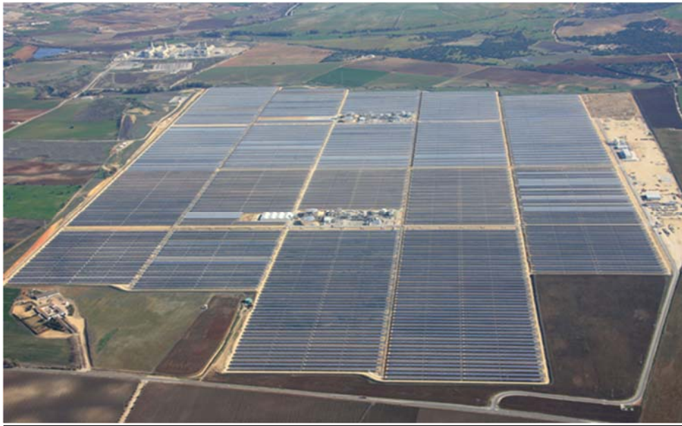
Εικόνα Α.24: Ηλιακός θερμικός σταθμός με παραβολικά κάτοπτρα, Valle Solar Power Station
