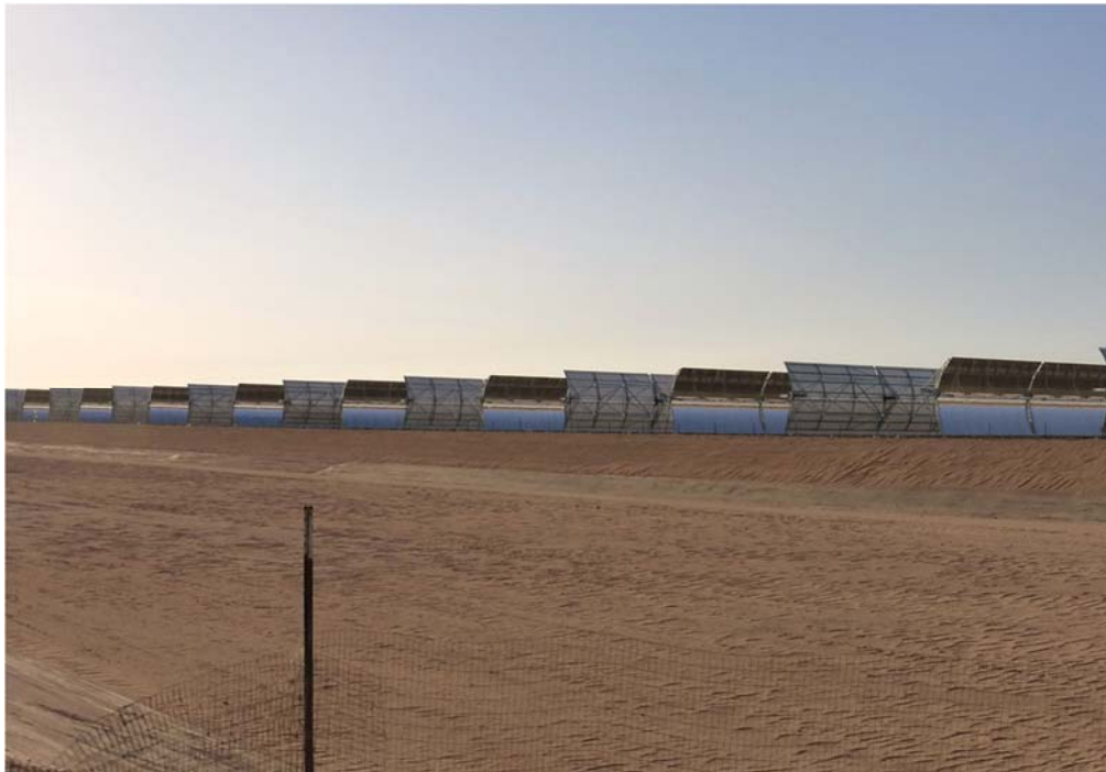
Εικόνα Α.22: Ηλιακός θερμικός σταθμός με παραβολικά κάτοπτρα, Mojave Solar Project
