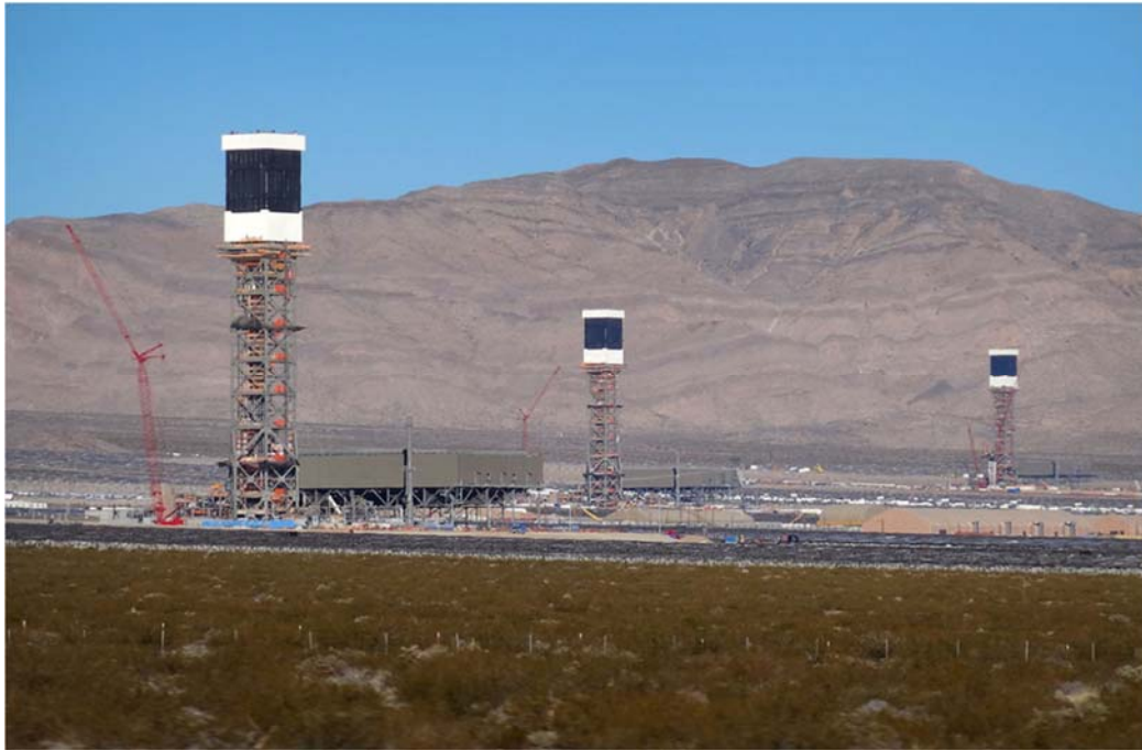
Εικόνα Α.21: Ηλιακός θερμικός σταθμός με ηλιακούς πύργους, Ivanpah Solar Power Facility
