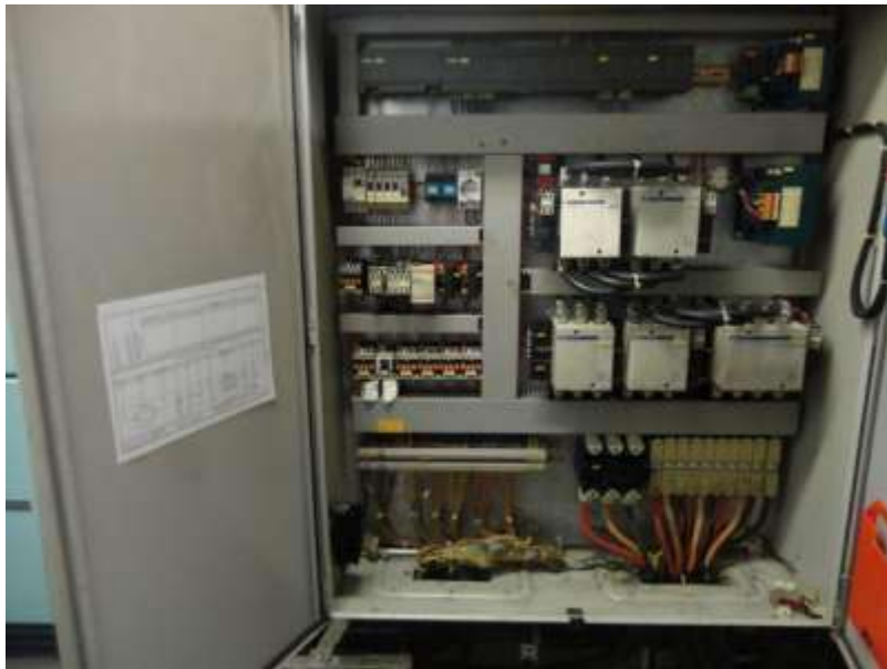
Εικόνα 5.1: Πίνακας εκκίνησης κινητήρα
