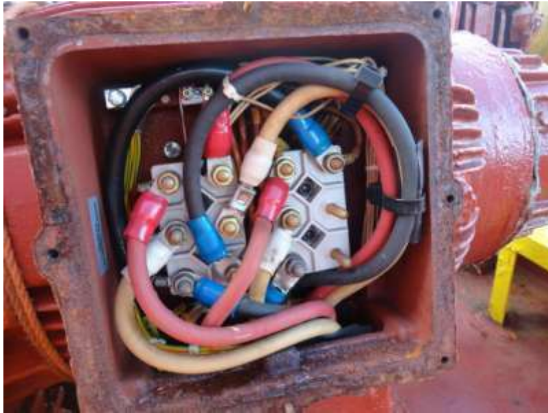
Εικόνα 5.2: «Κουτί» συνδέσεων επαγωγικού κινητήρα.
