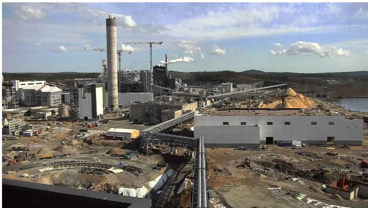
KUVA 2. Äänekosken sellutehdas ja uuden biotuotetehtaan rakennustyömaat (Metsä Fibre 2016-01-05).
