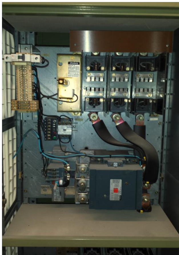
KUVA 5. Kiinteä lähtöyksikkö.
