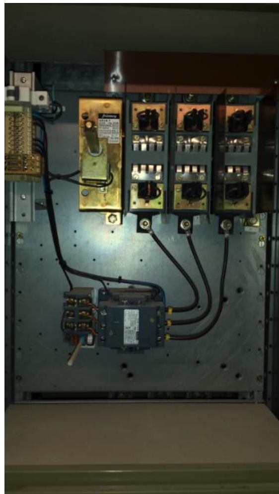
KUVA 14. Kenno, jossa kaikilla komponenteilla on yhteinen pohjalevy.
