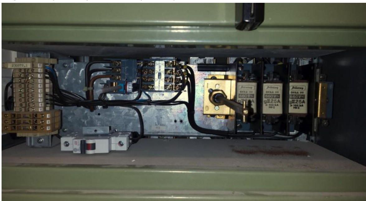
KUVA 16. Pienin moottorilähtökeskuksen kennokoko, joka tehtaalta löytyy.
