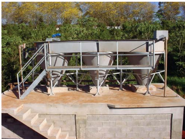
Fig. 2. Modelo de decantador cônico utilizado para separação sólido/líquida em dejetos animais.
