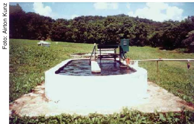
Fig. 4. Exemplo de valo de oxidação (também chamado de lagoa de alta taxa) utilizado no tratamento de dejetos de suínos.
