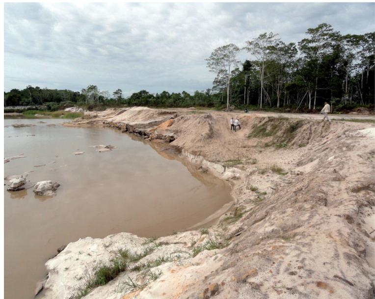
**Figura 4.24** - Extração de areia para construção civil a partir do horizonte eluvial de um espesso Espodossolo (vicinal de terra no município de Mâncio Lima).
