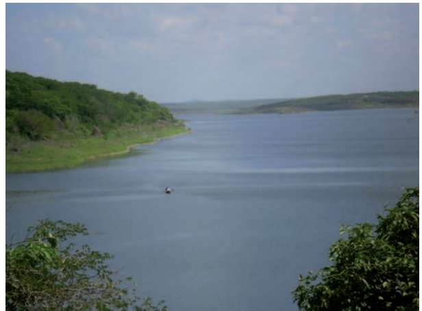
Figura 2.2.20 - Açude General Sampaio, localizado no município homônimo. O reservatório, construído no leito do rio Curu, tem capacidade para armazenar 322 milhões de m 3 de água.
