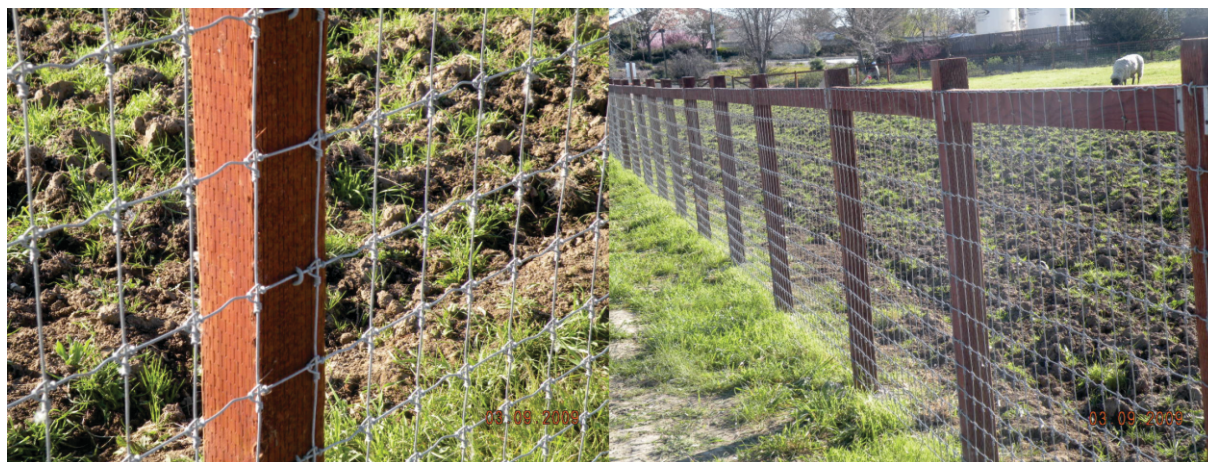
Figura 8. Cercas de telas e mourões de madeiras.
