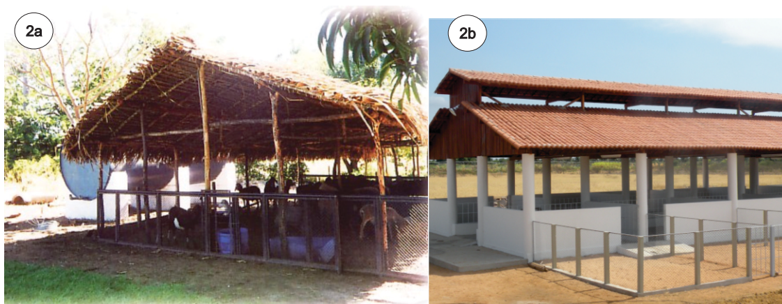
Figuras 2a e 2b. Aprisco rústico com cobertura de palha. Foto: Santos (2004) (a), Aprisco de alvenaria com cobertura de telhas cerâmicas, Univasf.
