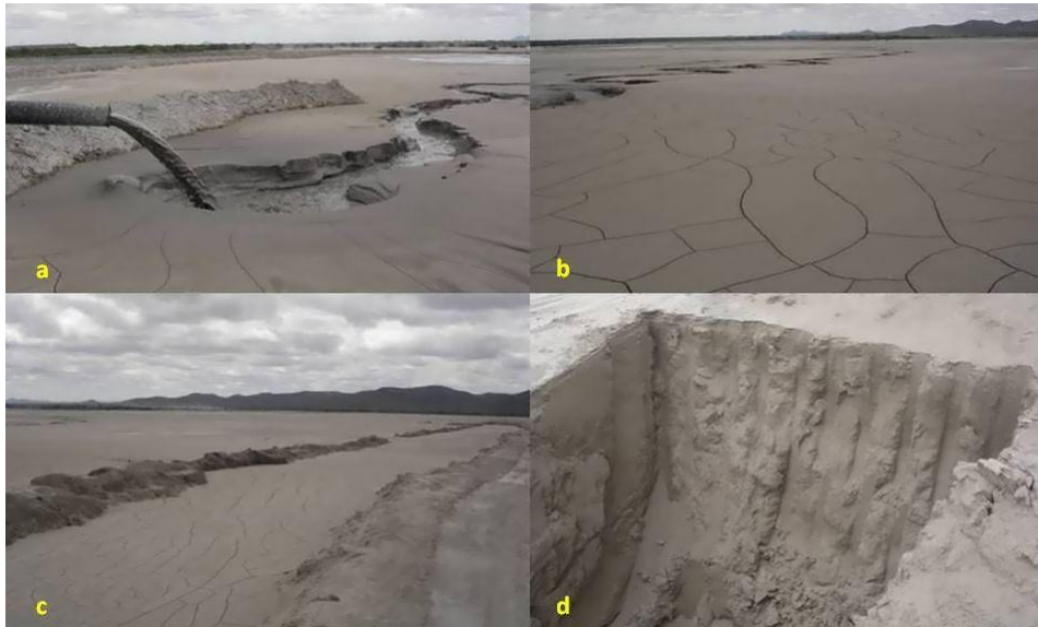
Figura 1. Vista geral da área de deposição de rejeitos finos da mineração de cobre oriundos do processo de tratamento do minério: a) deposição de rejeitos finos; b e c) vista geral da bacia de rejeitos; d) perfil da área de deposição de rejeitos finos. Área total de aproximadamente 700 ha. (Fotos: Marcos Antônio Drumond).
