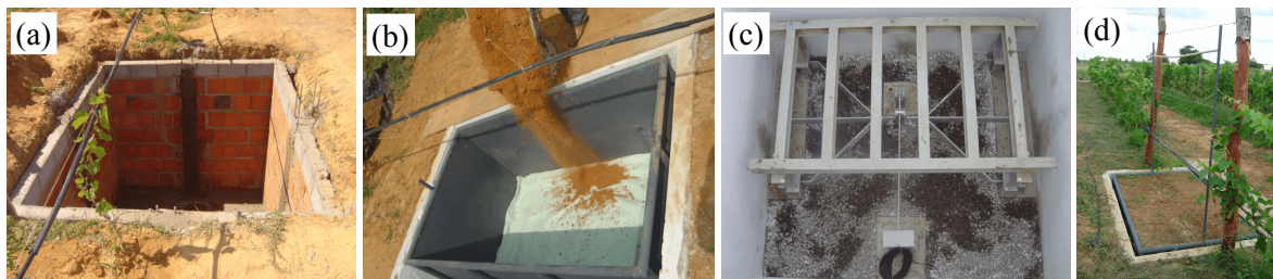
Figura 1 - Parede de alvenaria com colunas de concreto (a), preenchimento da caixa lisimétrica (b), sistema de balança (c) e lisímetro de pesagem após a montagem no campo (d).
