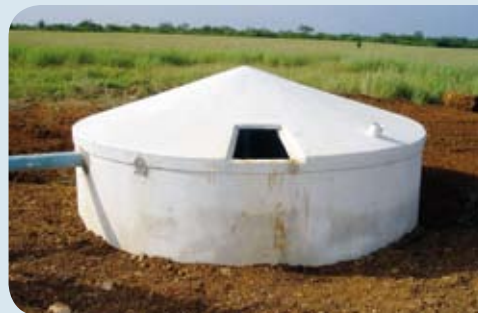
Fig. 5.7. Cisterna construída de placas pré-moldadas. (Foto: Magna S. B. de Moura, 2005)
