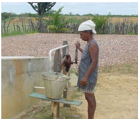
Cisterna com área de captação no solo revestido com lona plástica e brita, construída em 1982.
