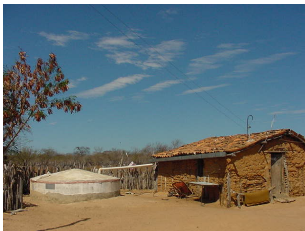
Figura 4. Residência com calha para captação de água da chuva apenas em 50% do telhado na comunidade de Cacimba do Baltazar (Petrolina - PE).
