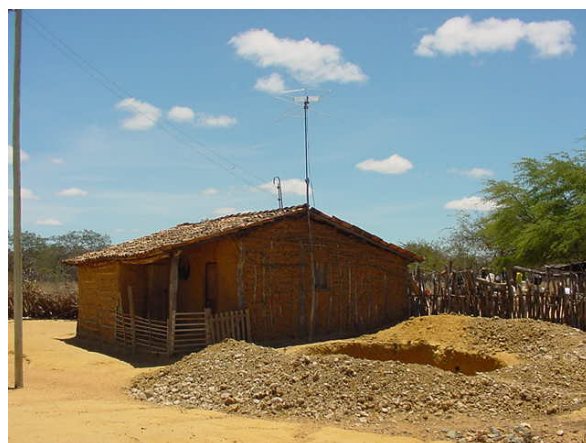
Figura 3. Residência na comunidade de Sítio Caldeirãozinho (Petrolina - PE) com cisterna em fase de construção.
