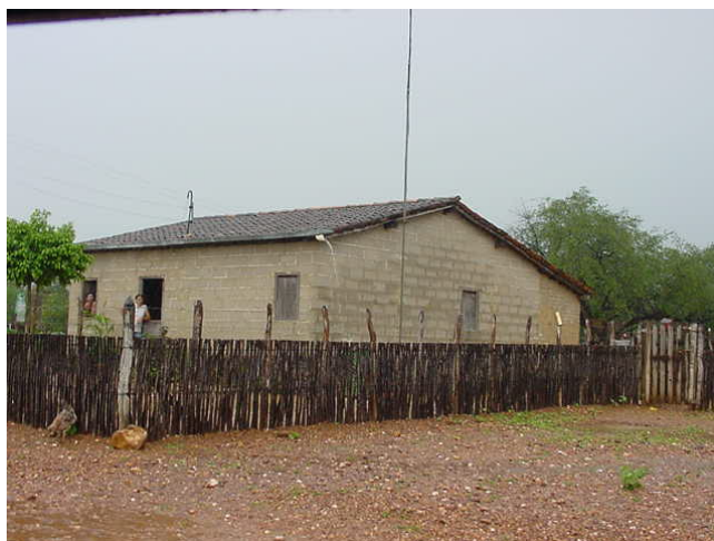
Figura 1. Água da chuva sendo desperdiçada em residência sem calhas para captação da água para cisterna na comunidade de Varginha (Petrolina -PE).
