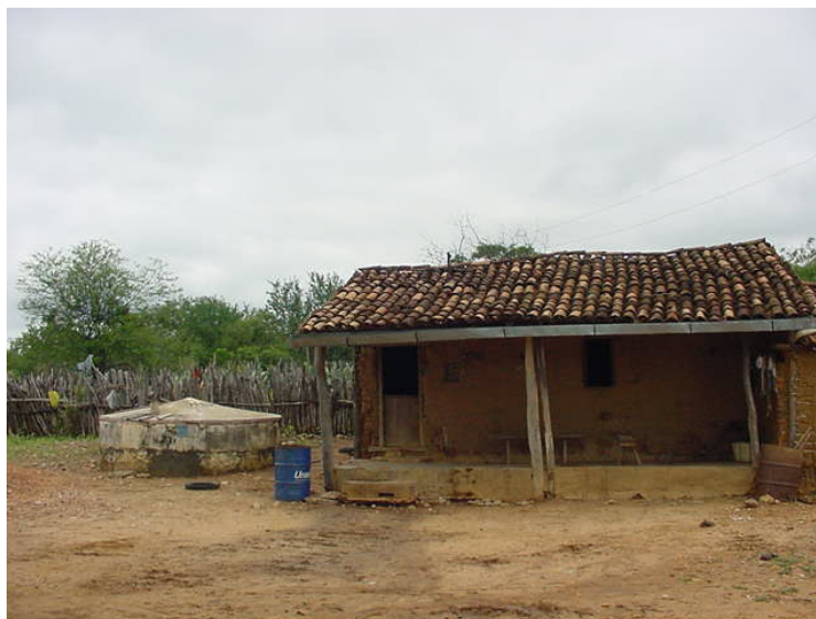
Figura 1. Cisterna tipo placas utilizada pelos agricultores da comunidade de Jatobá da Cumprida, Petrolina-PE.
