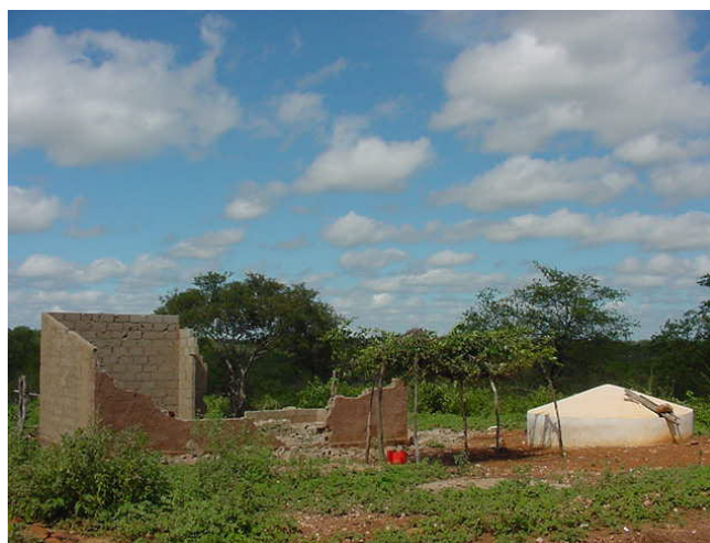
Figura 3. Cisterna em residência sem família na comunidade de Cacimba do Bonfim, Petrolina-PE.
