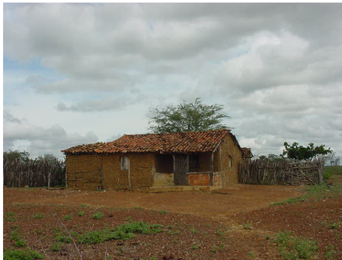
Figura 5. Casa sem cisterna na comunidade de Budim, Petrolina-PE.
