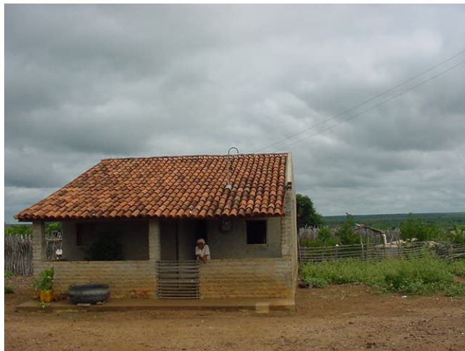
Figura 4. Residência com cisterna sem calhas para captação e condução de água na comunidade de Cacimba do Bonfim, Petrolina-PE.
