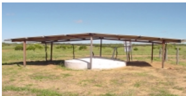
Figura 6. Cisterna rural de placas pré-moldadas
