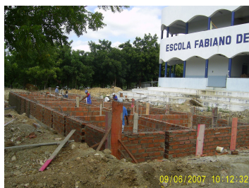
Figura 10 – Construção da cisterna da escola Fabiano de Cristo (Santa Bárbara)
