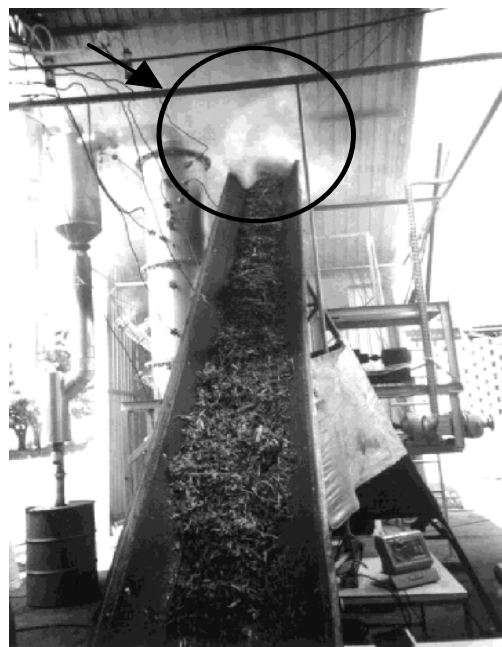
Figura 2. Vazamento de gases do reator de pirólise pelo sistema de alimentação de biomassa.
