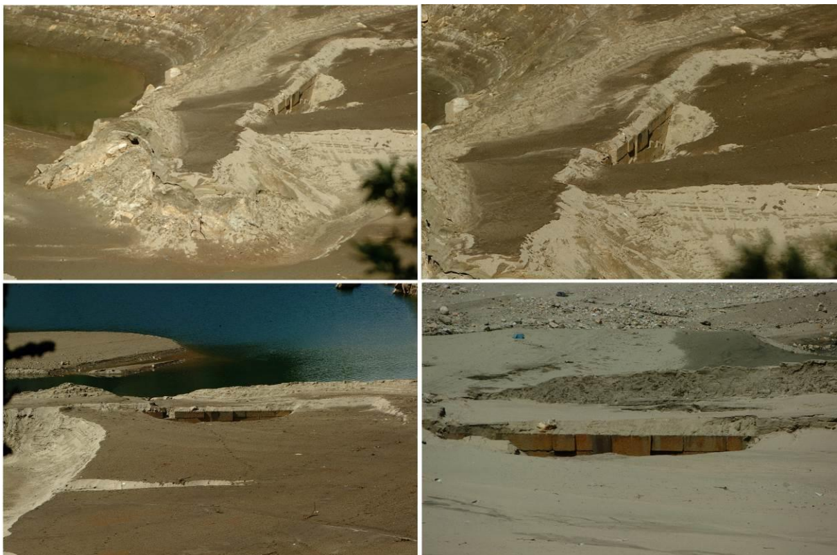
Figura 182: Fotos de 2001 da Ponte do Arco, estando bastante assoreada (fotos de José Teixeira).
