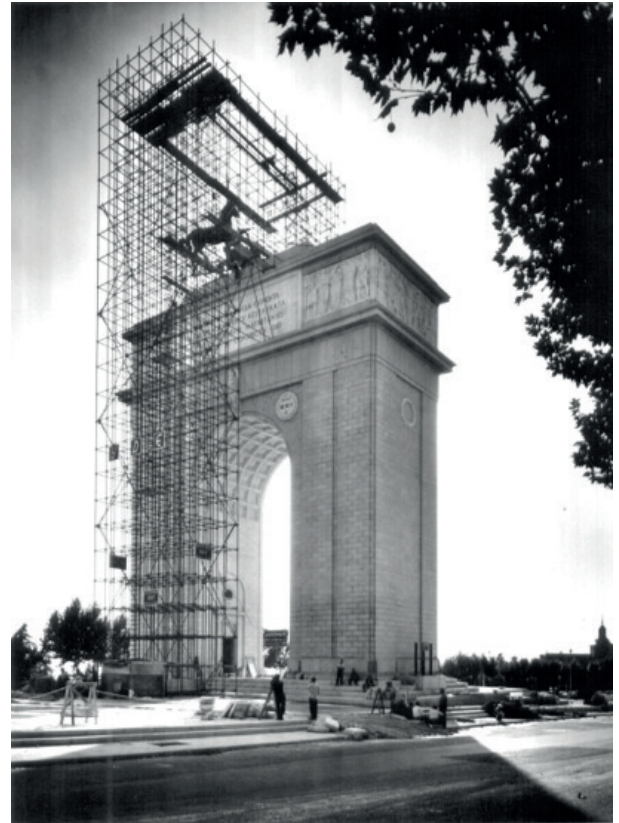
Colocación de la cuadriga sobre Arco de la Victoria. Ca. 1953. Archivo Pando. Instituto del Patrimonio Cultural de España.
