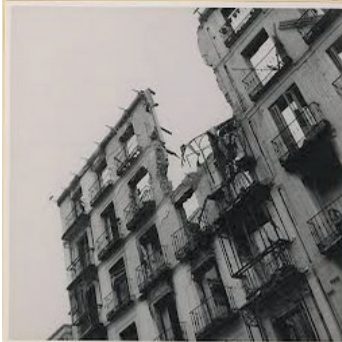
Edificios derruidos en Argüelles. Archivo Rojo, AGA.
