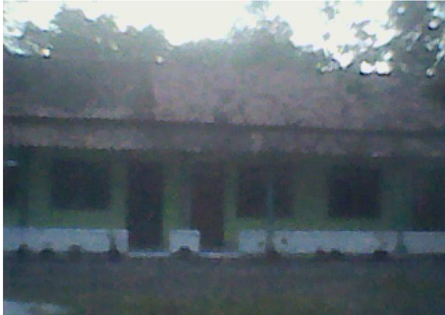
9. Gedung MDA Al Muttaqien Desa Pucangrejo.
