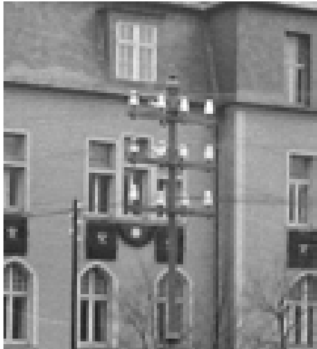
Abb. 241a, b, d, e, f: (beide oberen Reihen) Verschiedene Entwicklungsphasen am Mast zwischen dem Balkon des Oberbergamtes und dem Roemer-Denkmal. Zunächst ist es ein Holzmast mit Metallkappe, später ein Metallmast mit Querträgern. (aus Abb. 138; 157b; 064b; Glasplatte 1-2, Archiv TU; aus Abb. 157a)
