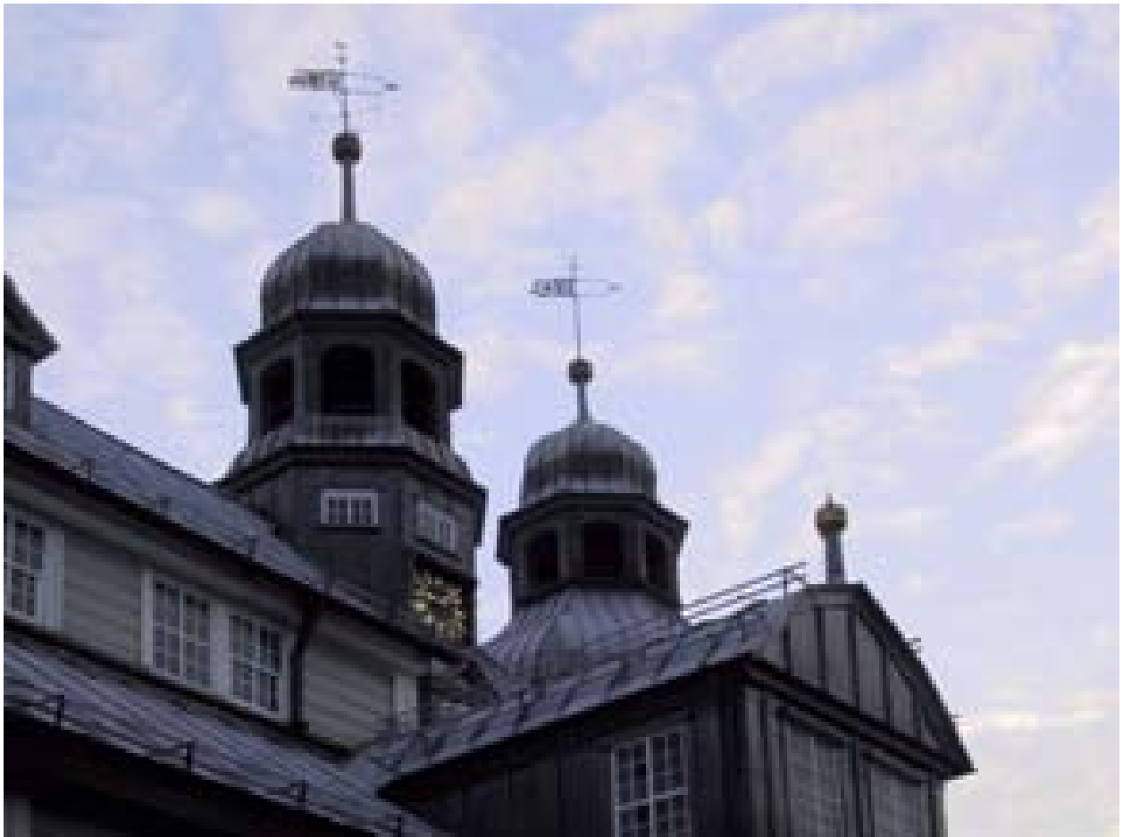
Abb. 029a: Dachstuhl über dem Kirchenschiff. (FB) Abb. 029b: Die Wetterfahnen der Marktkirche stammen aus dem Jahre 1866. Alle Dächer sind mit Blei gedeckt. (FB)
