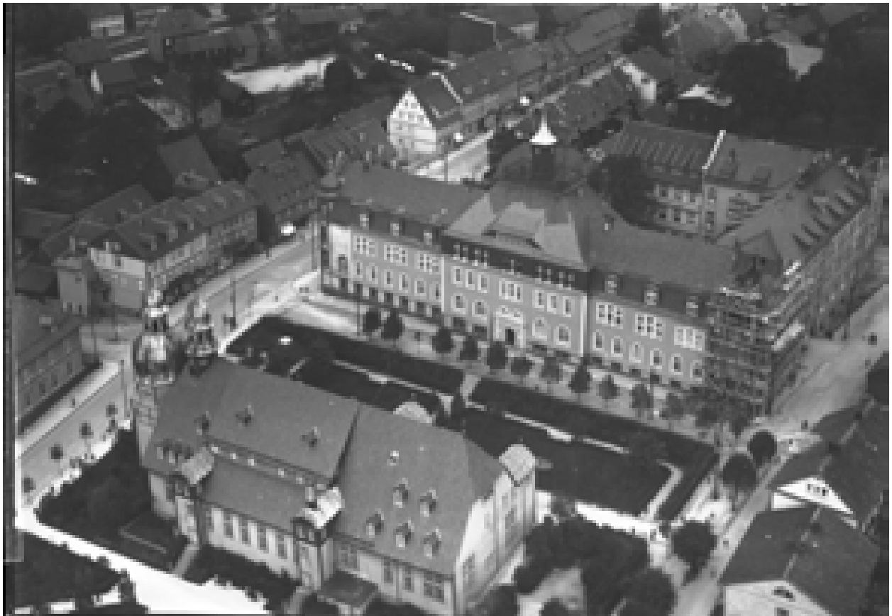
Abb. 151a: Der Marktplatz aus der Luft, 1930-er Jahre. Das Kirchendach ist mit Schiefer, die Türme und die Kappen der Treppenhäuser sind mit Blei gedeckt. (Glasplatte 3-32, Archiv TU)
