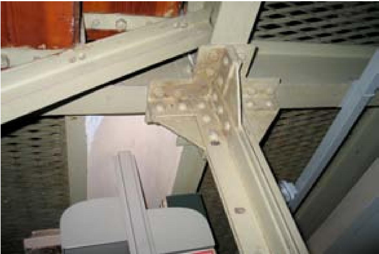
Abb. 104a und b: In der Bibliothek stehen die Bücher auf einem eisernen Hochregal. Die Bauelemente sind teilweise genietet oder geschraubt. (FB)
