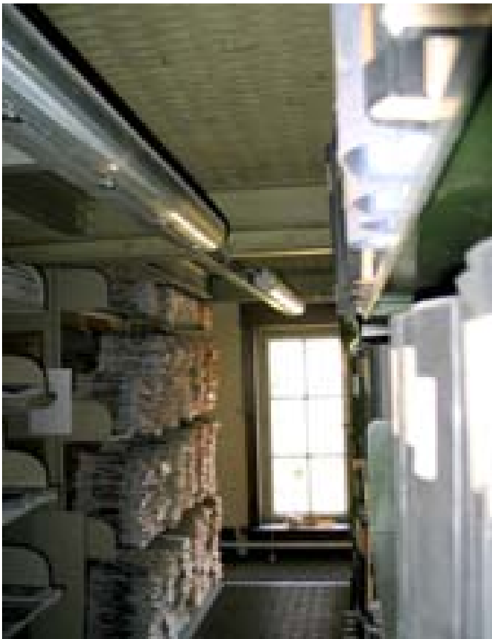
Abb. 104a und b: In der Bibliothek stehen die Bücher auf einem eisernen Hochregal. Die Bauelemente sind teilweise genietet oder geschraubt. (FB)
