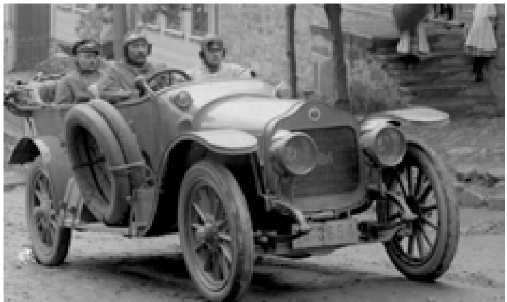
Abb. 247b: Nägel auf der Lauffläche sollen den Reifen wahrscheinlich eine größere Lebensdauer bei den schlechten Straßen hier im Harz verleihen. Auch die
