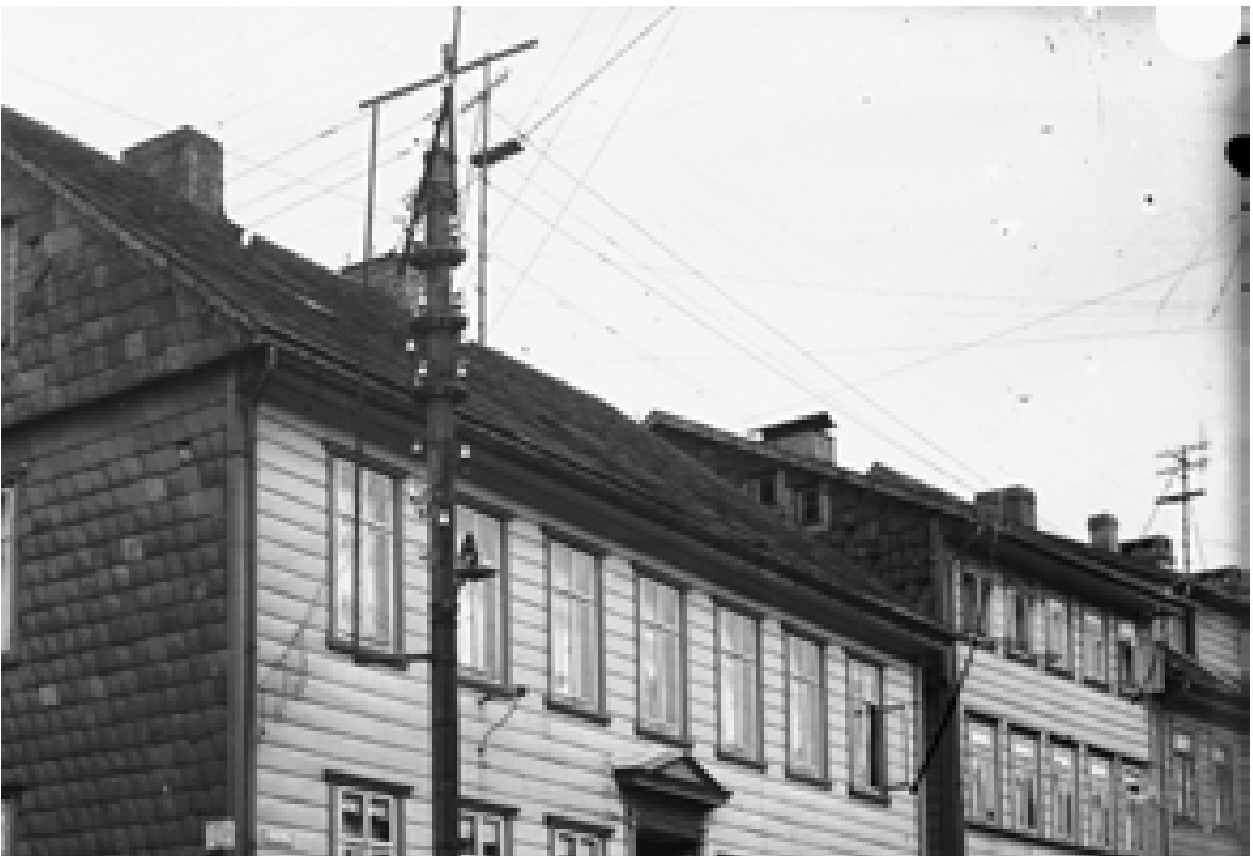
Abb. 242a: Starkstrom- und Telefonleitungen verlaufen getrennt. Während eine der ersten Telefonleitungen vor dem Oberbergamt (oberes Bild, rechte untere Ecke) in der Straße gespannt ist, trägt das Gestell auf dem Rathausdach ein ganzes Bündel von Drähten. (aus Glasplatte 646, OBM)
