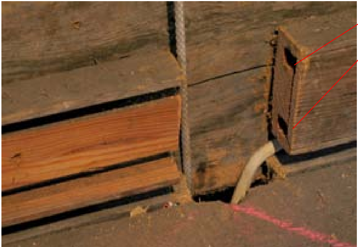
Abb. 044b, 045a und b: Als eine der ersten Kirchen Deutschlands besaß die Marktkirche um 1900 elektrisches Licht. Die Zuleitungsdrähte lagen einzeln in hölzernen Kabelkanälen, die wie hier am
