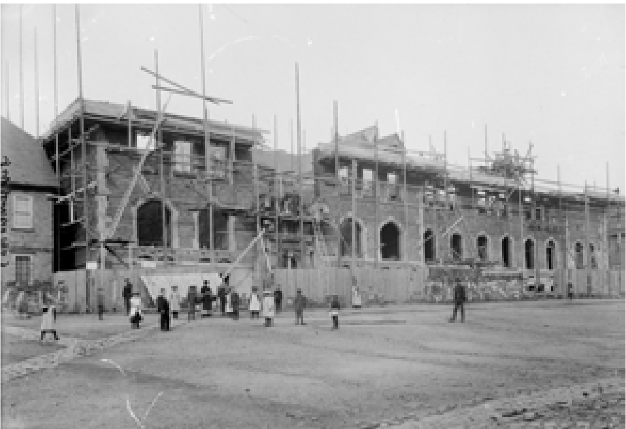
Abb. o62a, b und o63a: Der östliche Teil des neuen Hauptgebäudes nimmt Gestalt an. Damals benutzten die Bauarbeiter hölzerne Gerüste. Baumaterialien
