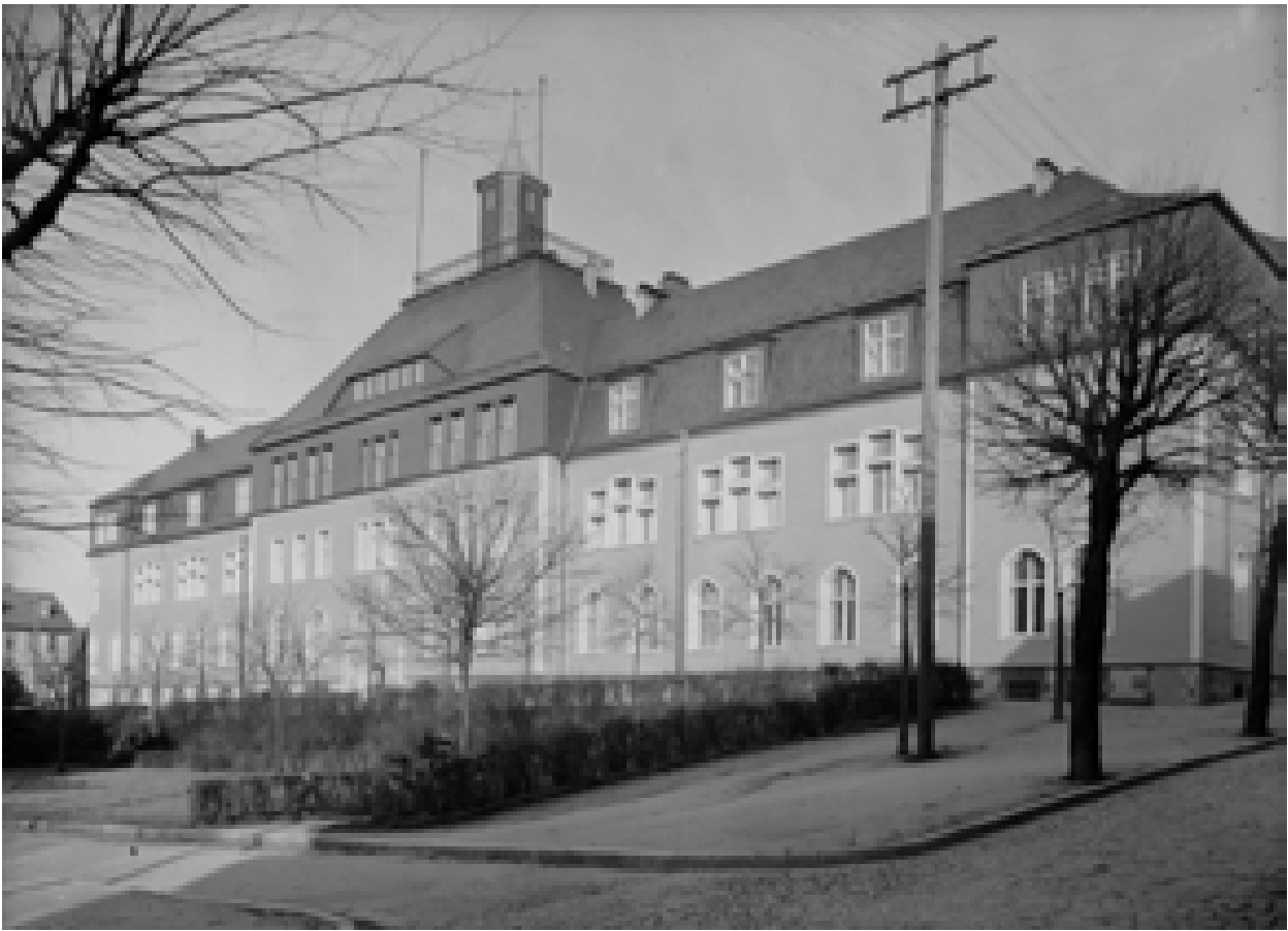
Abb. 158a: Noch gibt es einen Beobachtungsturm auf dem mittleren Dach. (Glasplatte 3-35, Archiv TU)
