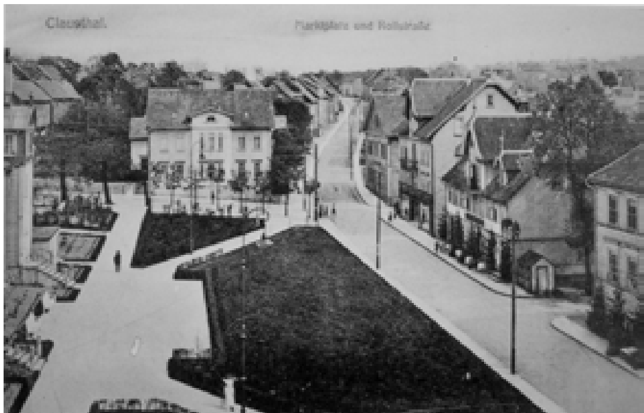
Abb. 131a: Blick vom Oberbergamt über den unteren Markplatz. In der Bildmitte verläuft die Rollstraße bergauf. (Sammlung Seidel: 7620)
