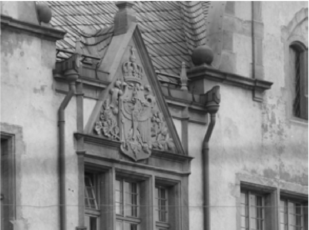
Abb. 164a: Krone und Adler an der Fassade. (Ausschnitt aus Abb. 067b)
