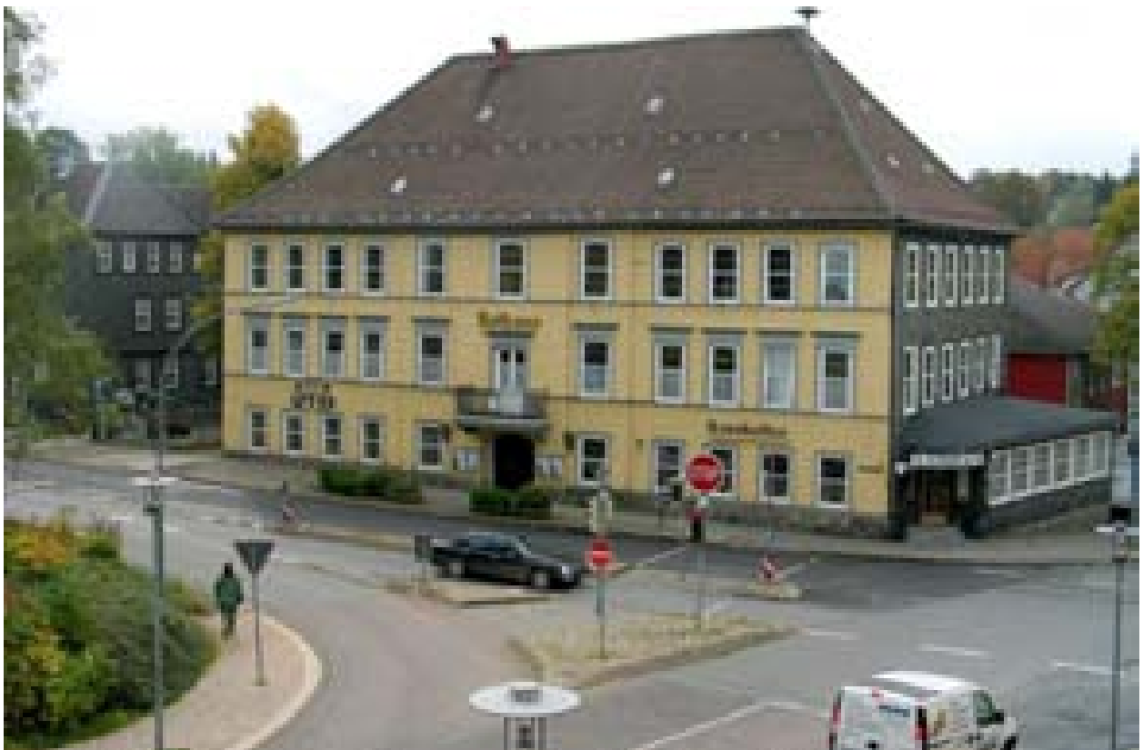
Abb. 125b: Nach Verbreiterung der Straßenkreuzung ist nun das Rathaus vom Marktplatz getrennt, während beide auf den Bildern der linken Seite noch eine funktionelle Einheit bilden. (FB)
