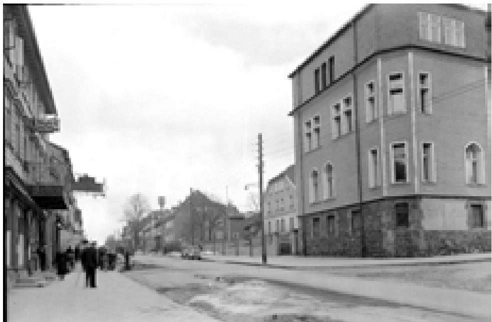
Abb. 154a: (o.) An der südwestlichen Ecke des Hauptgebäudes mit dem alten Laborgebäude von 1875 begrenzen jetzt Bordsteine die Goslarsche Straße. Früher waren hier Pflastersteine. In der Bildmitte schaut der Giebel des Probierlaboratoriums von 1841 heraus, vergl. Abb. 069b. (Glasplatte 3-59, Archiv TU)
