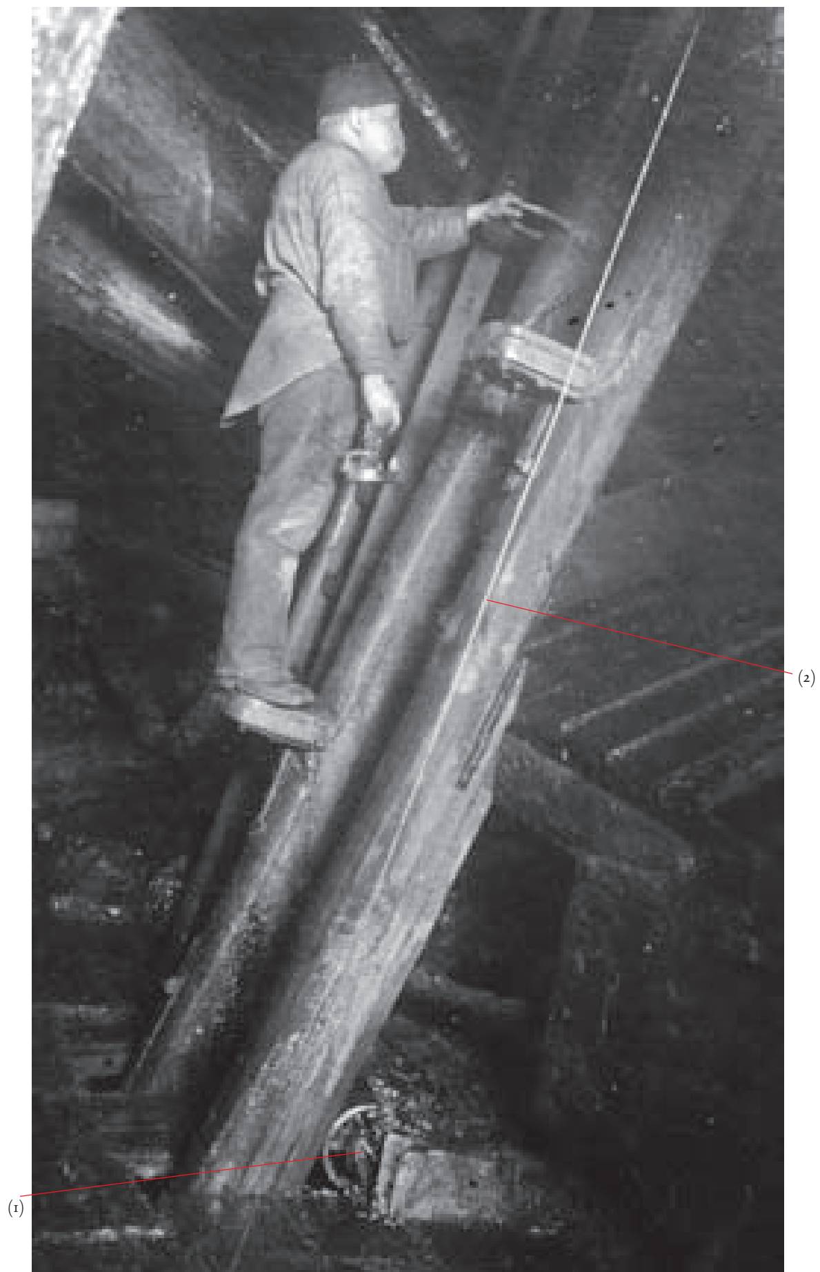
Abb. 113: Bergmann auf der Fahrkunst. Die Holzstangen mit Kufen gleiten auf eisernen Rollen (1) (vergl. Abb. 204.1). Im Vordergrund hängt ein Seil (2) zum Signalgeben. (Foto A. Borrmann)
