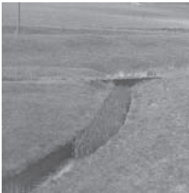
Abb. 133.4 und 5: Der obere Zulauf zur Wasserkreuzung ist im Jahre 2002 noch in Holz gefaßt. (FB)
