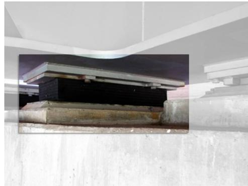
Abbildung 6.24.: Elastomerlager im Einbau
