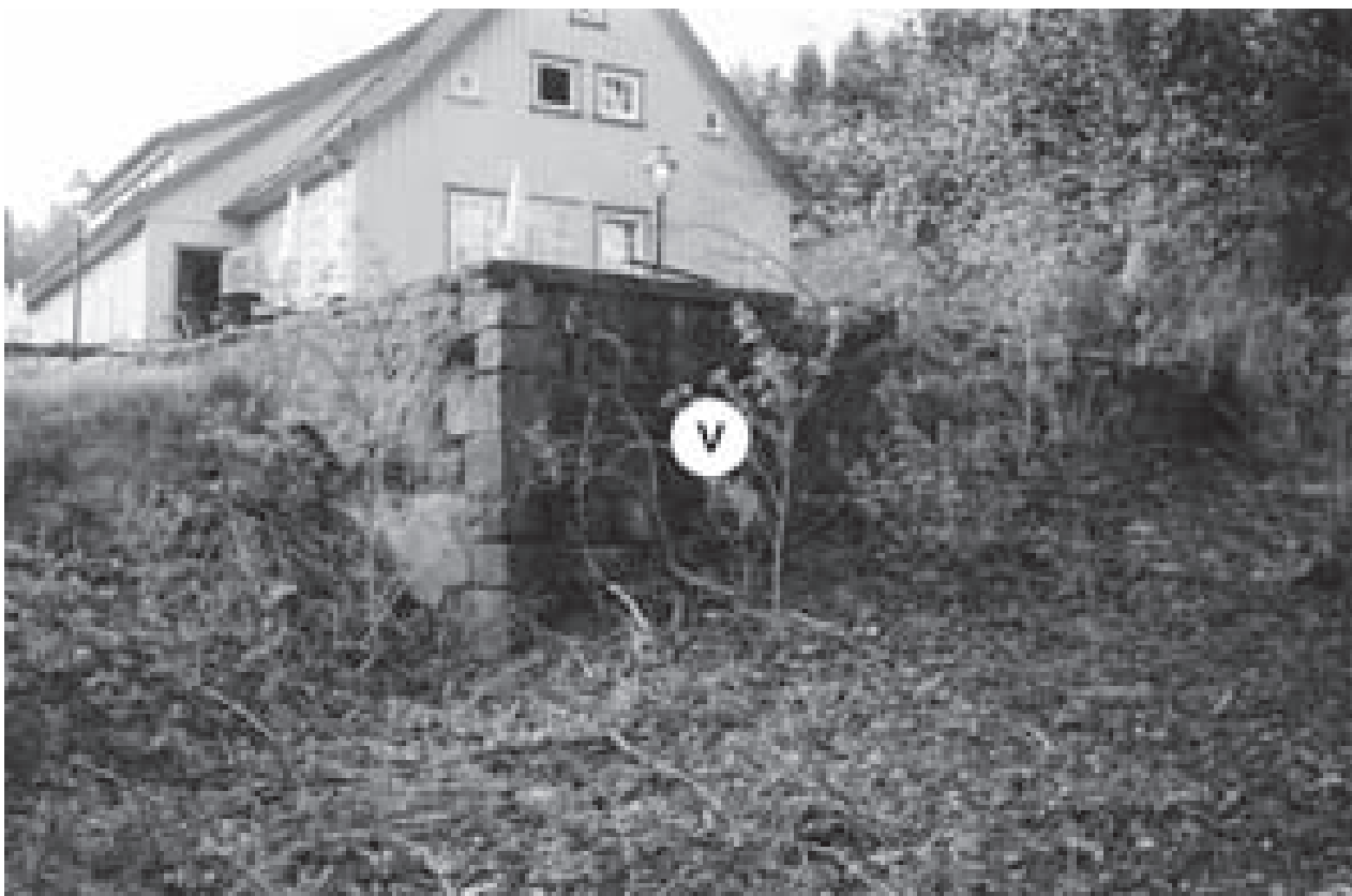
Abb. 35: Ringer Zechenhaus mit Wasserzulauf. Im Vordergrund die Mauer mit der Zulaufrösche für das Kehrrod des Schachtes Rheinischer Wein.
