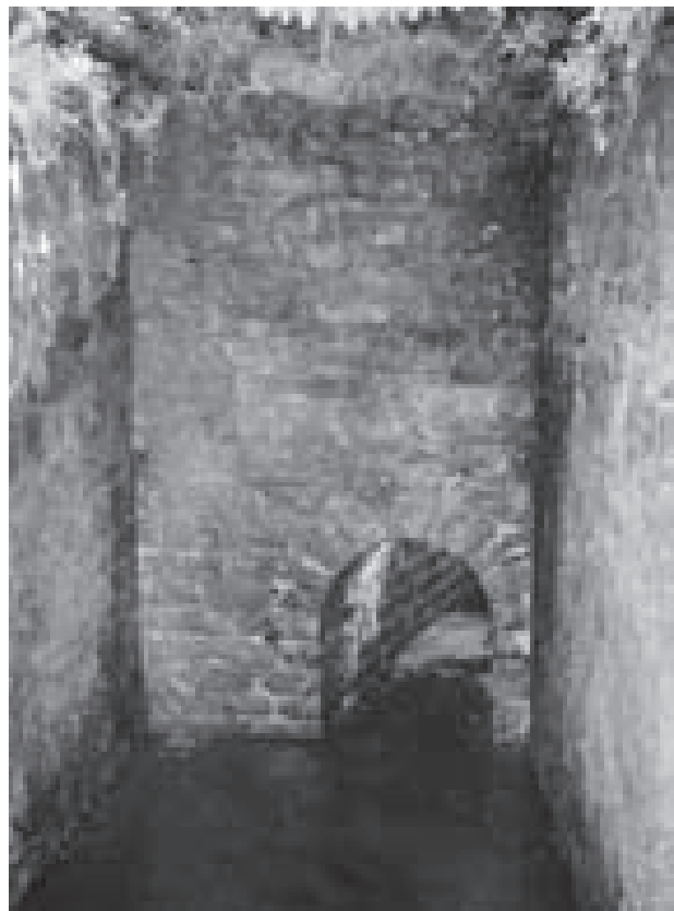
Abb. 58: Obere Kunstradstube am Polsterberg. Talseitige Stirnwand mit kunstvoll gemauerter Ablaufrösche.
