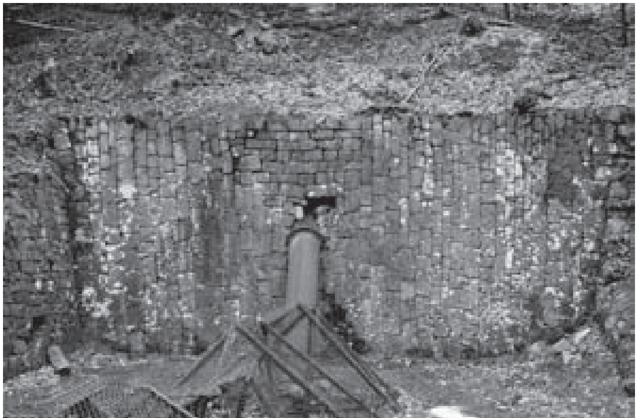
Abb. 43: Hangseitige Stützmauer an der Kunstradstube Knesebeck-Schacht vor der Sanierung.
