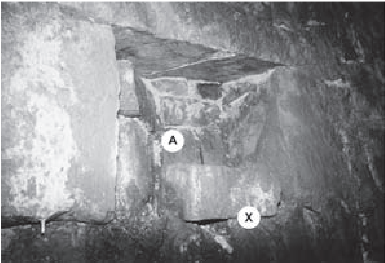
Abb. 13: Runde Radstube. Einzelheiten der Öffnung A mit Unterlegstein.
