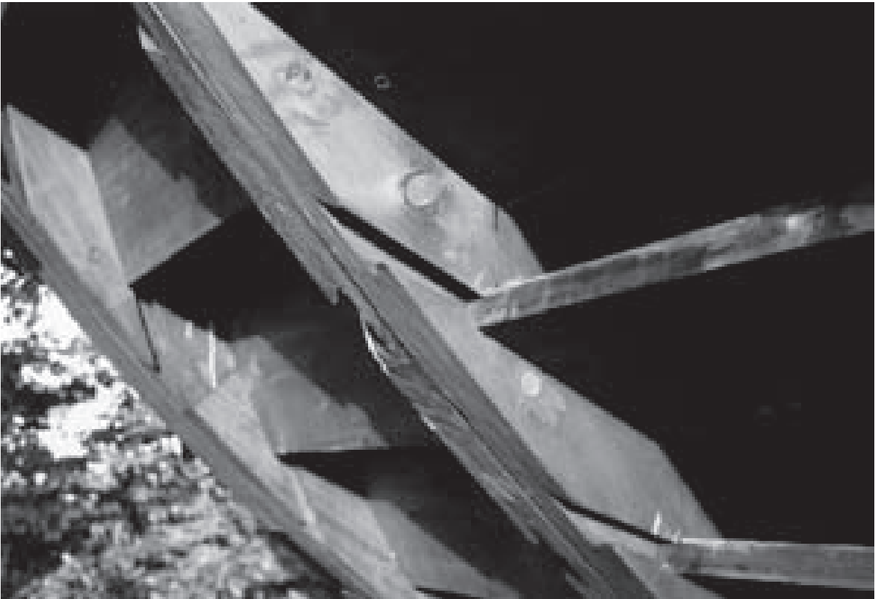
Abb. 108: Mit Schwalbenschwänzen sind die Schaufelbretter im Kranz verankert (H. Calvör). Nachbau durch H. H. Nietzel auf dem Gelände der Harzwasserwerke.
