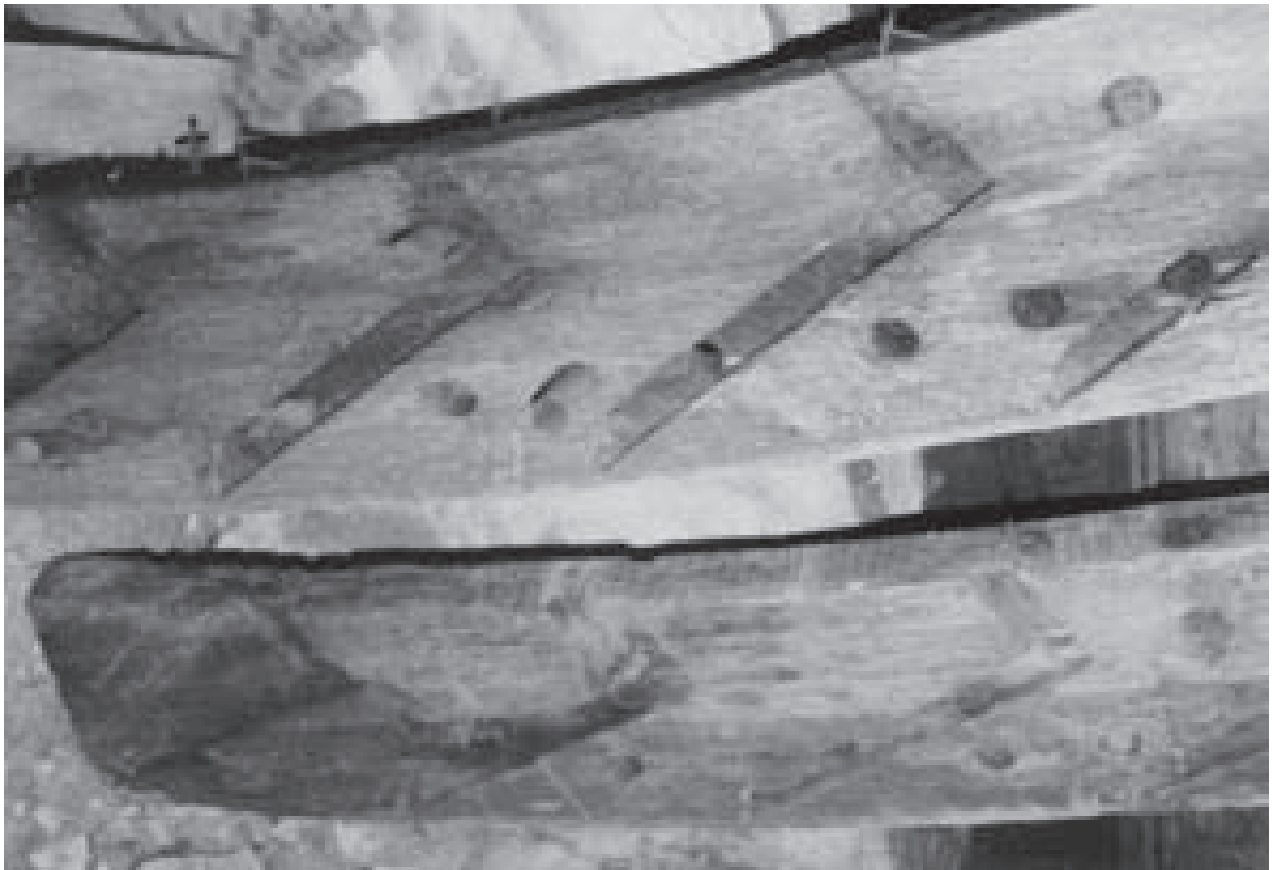
Abb. 109: Bohrschema der Holznägel am Kranz. Kehrrad der Grube Samson in Sankt Andreasberg.
