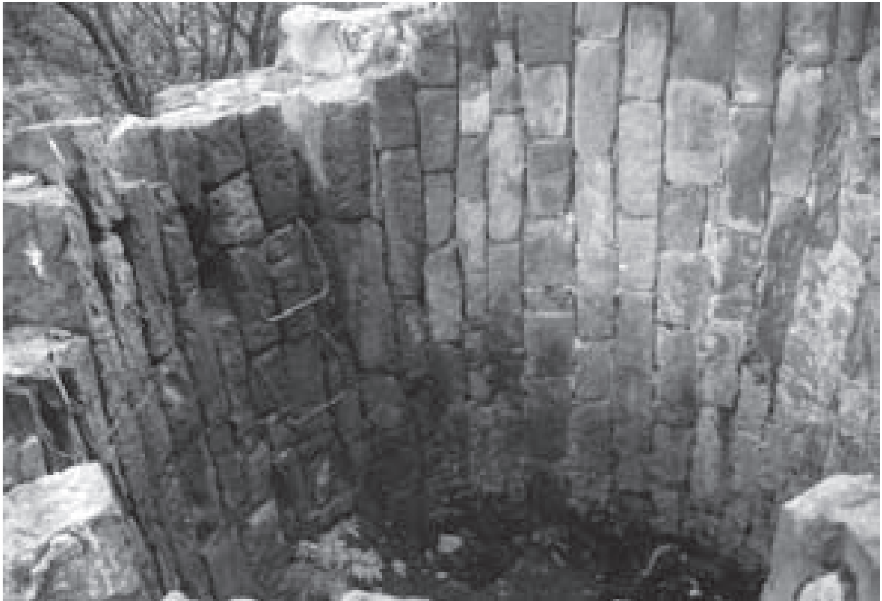
Abb. 17: Schornsteinfuß der alten Aufbereitung. Sorgfältig gesetzte Steine mit kleinen Fugen, senkrechte Laufrichtung.
