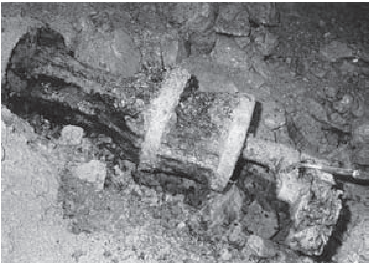
Abb. 96: Kummelsglück. Reste der Welle mit Kurbelzapfen (W. Lampe).
