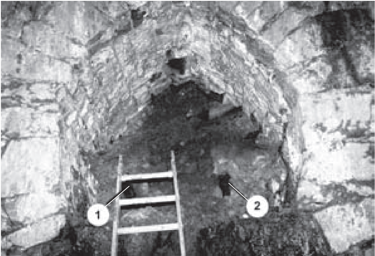
Abb. 12: Runde Radstube. Beim Aufwältigen werden die Reste des hölzernen Kastens für den Wasserzulauf (Gefluder) sichtbar.
