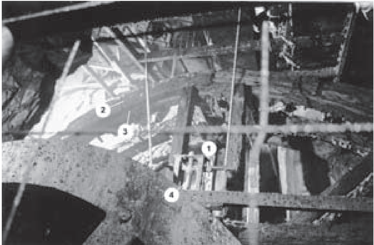
Abb. 115: Kehrrad am Ernst-August-Schacht in Wildemann, Kranz mit zusätzlichen Laschen des Bremsrades.
