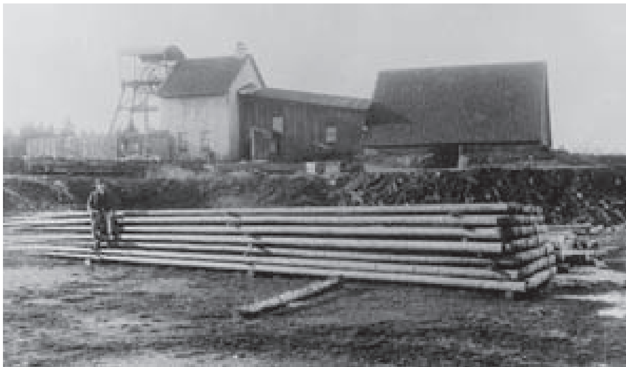
Abb. 22: Anna Eleonora. Fördergerüst mit Radstube, Ansicht von Osten (Harzbibl.).
