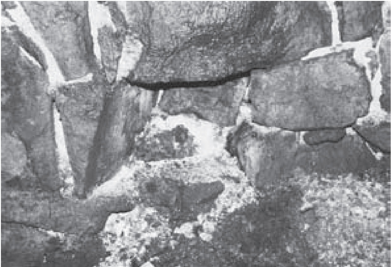
Abb. 15: Runde Radstube. Kleine Öffnung im unteren Teil.
