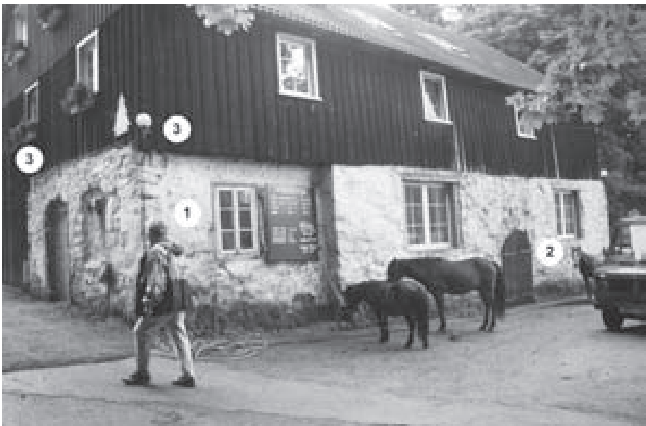
Abb. 28: Kehrradstube der Grube Jungfrau, heutiger Zustand. Der weiße Sockel ist die Mauer der ehemaligen Radstube.
