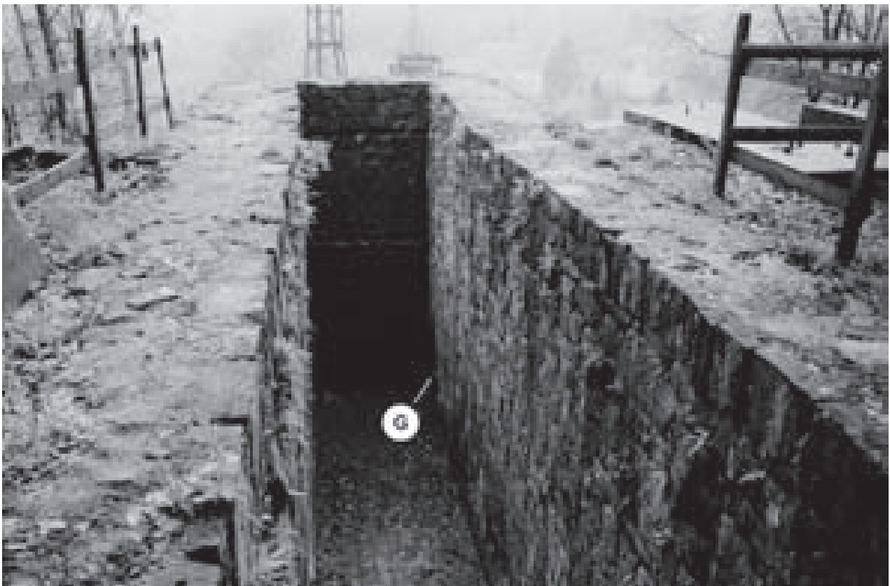
Abb. 45: Kunstradstube am Kneesebeck-Schacht nach der Sanierung.
