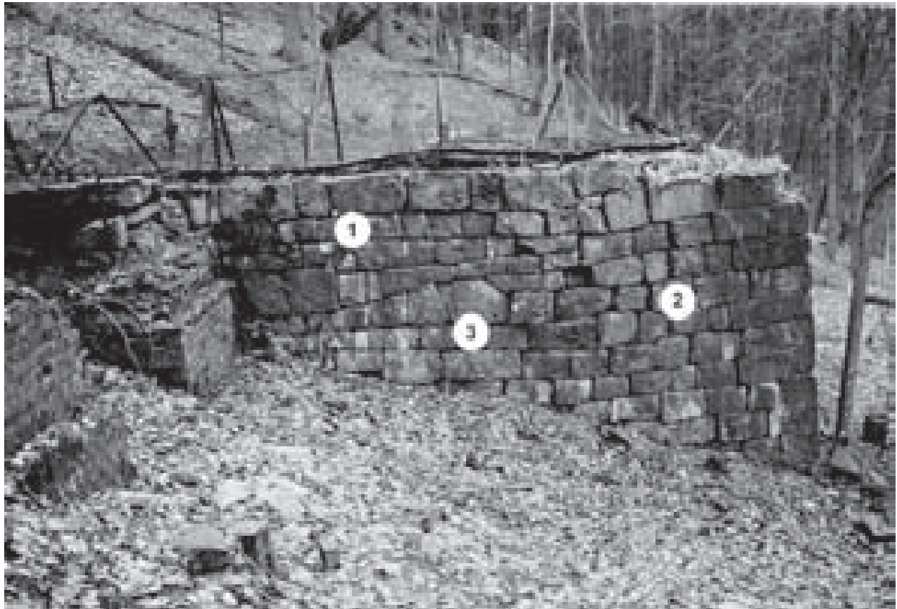
Abb. 42: Kunstradstube am Knesebeck-Schacht. Der Trog hebt sich an der Talseite aus dem Gelände heraus.
