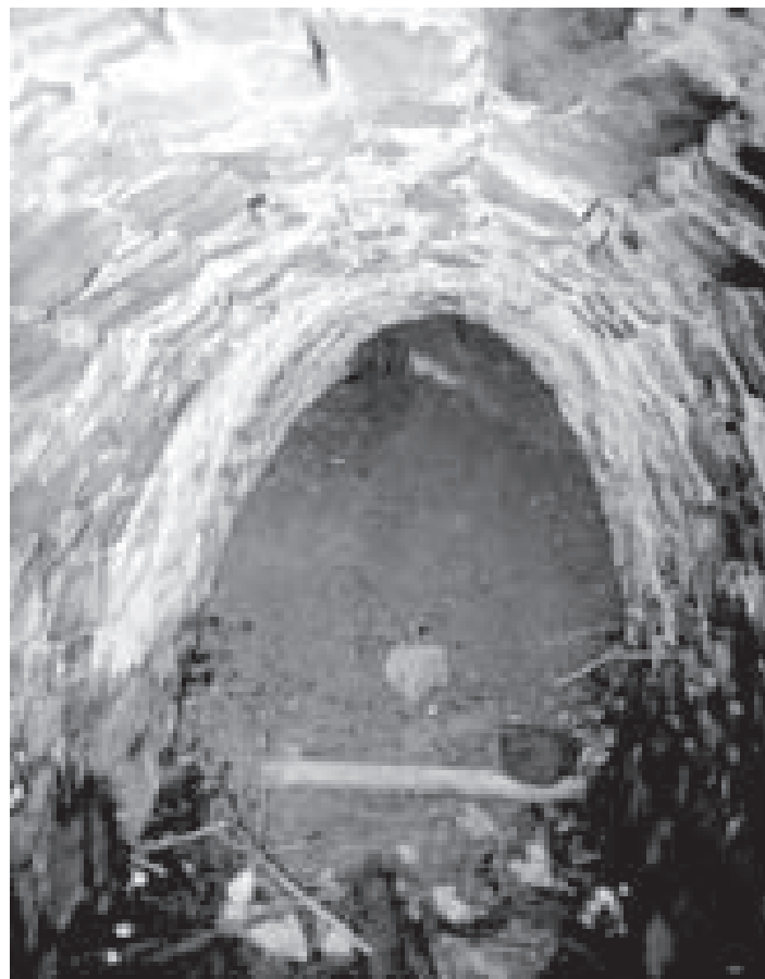
Abb. 64: Ablaufrösche der Kunstradstube am Zellerfelder Hoffnungsschacht.
