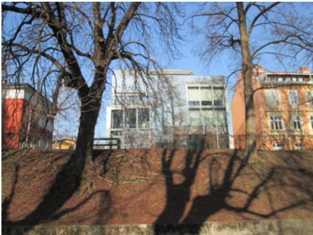
Fotografija 43: Sara Mihalič Deškovič: Spodnji pogled na stanovanjsko hišo Gradaška. 2016.
