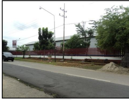
Gambar 4.11 Instalasi listrik (PLN)
