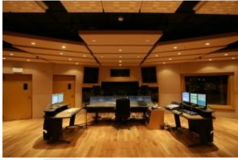
Gambar 2.45 Plafon sebuah aula dengan pelapis multiplek
