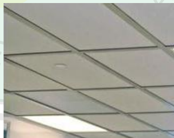
Gambar 2.43 Panel kayu yang ditempel di plafon
