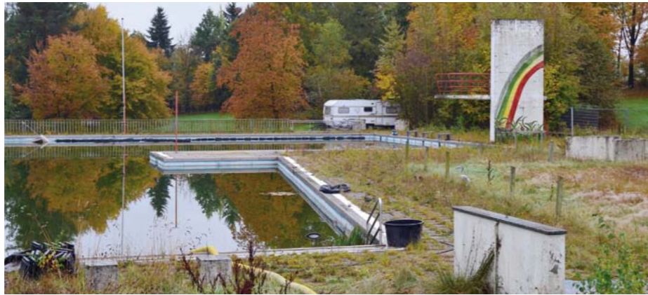
Die Schwimmbad-Brache in Brand, Oberpfalz: Blick auf Schwimmbecken und Sprungturm
