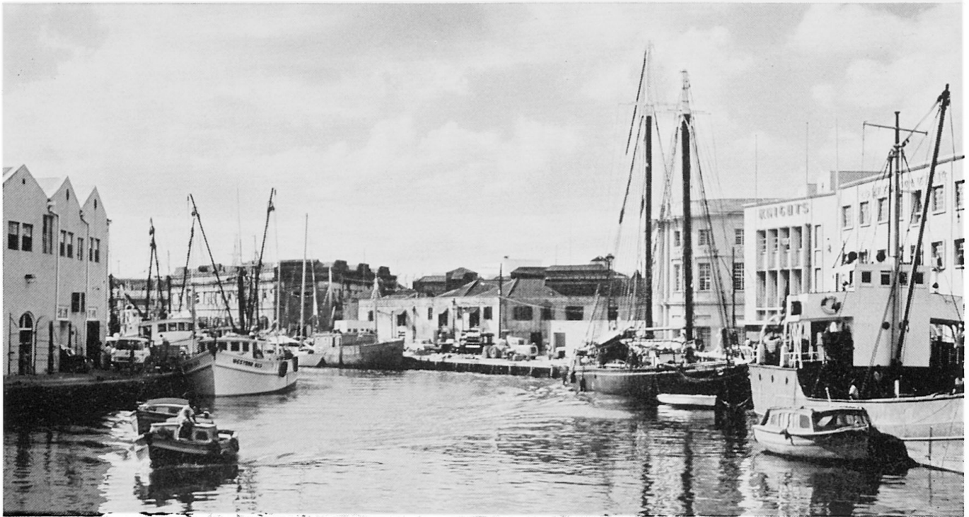
Abbildung 4. Eine kleine Meeresbucht, die tief ins Land hineinreicht, bildet mitten im Stadtzentrum von Bridgetown einen geschützten Naturhafen. Die Careenage ist Anlegestelle für die Antillen-Schoner, die den Lokalverkehr zwischen Barbados und den anderen Westindischen Inseln besorgen
