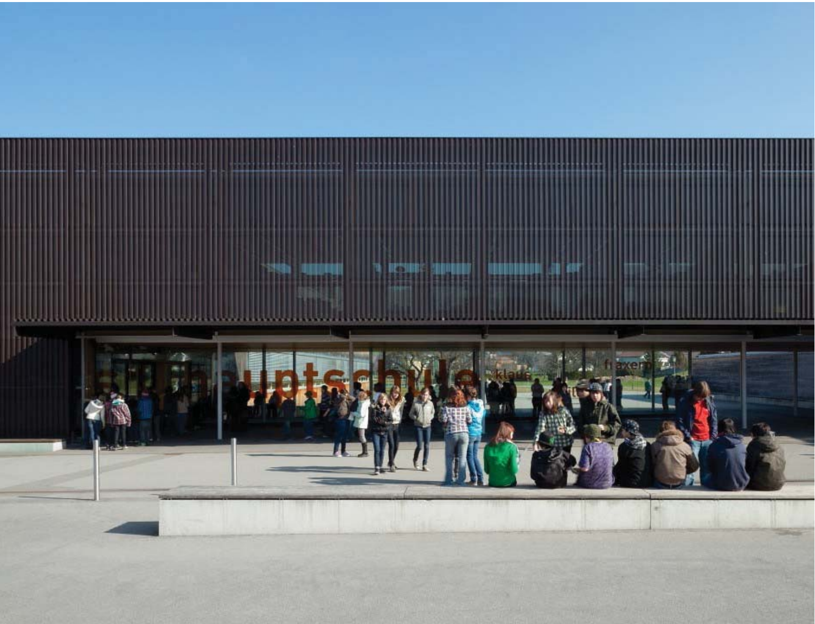
Hauptschule, Klaus, Austria. Dietrich Untertrifaller Architekten
