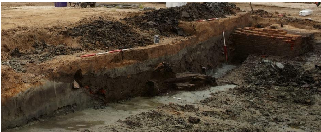
Figuur 75: beeld op profiel F van coupe E/F op de brugconstructie met balken en bakstenen brugpijler.
