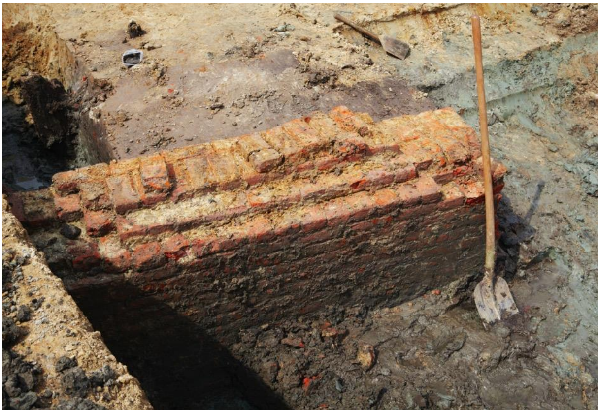
Figuur 77: bovenaanzicht van westelijke brugpijler.
