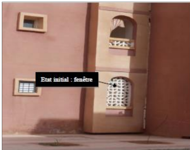
Figure 20. L'état initial avant transformation (Auteurs, mars 2017)
