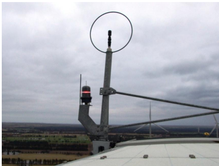
Figura 51 - Anemómetro de resonancia en góndola, detalle
