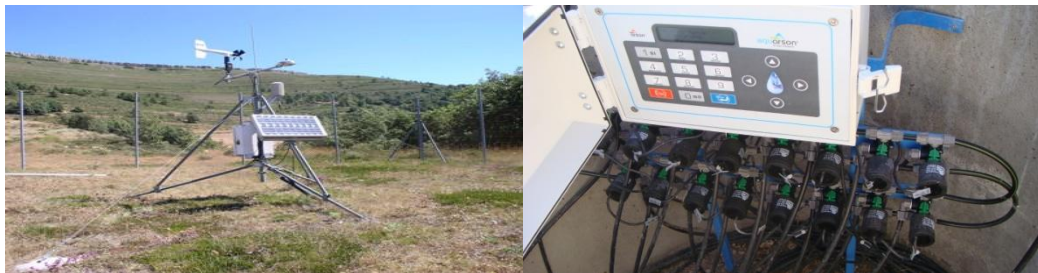
Figura 2.22. Estación meteorológica inalámbrica (izquierda) y monitorización de aguas (derecha)
