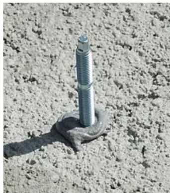
Fig. 40 Fijación química y varilla roscada
