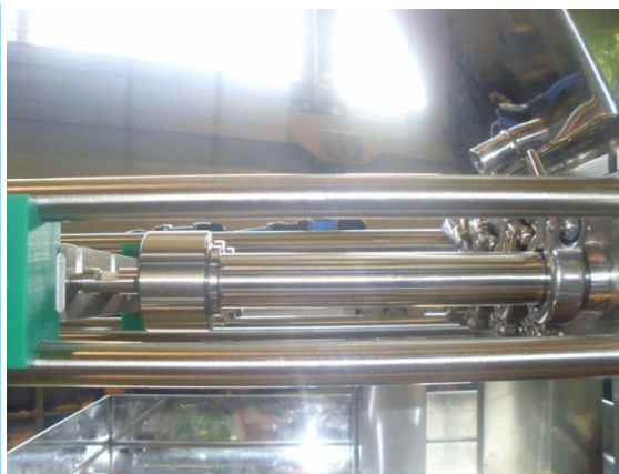
Figura 51. Columnas de la bomba.
